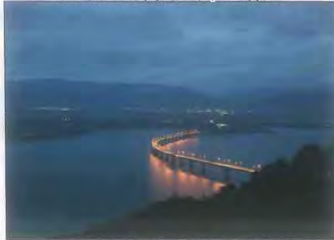
Εικόνα 17. Υψηλή Γέφυρα Σερβίων
