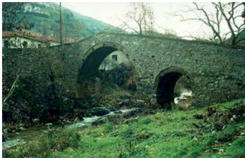
Εικόνα 16: Τοξωτή Γέφυρα Κερασιάς
