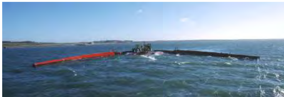
Εικόνα 21. Η πρωτότυπη διάταξη Wave Dragon κλίμακας 1:4,5 στην περιοχή Nissum Bredning της Δανίας
