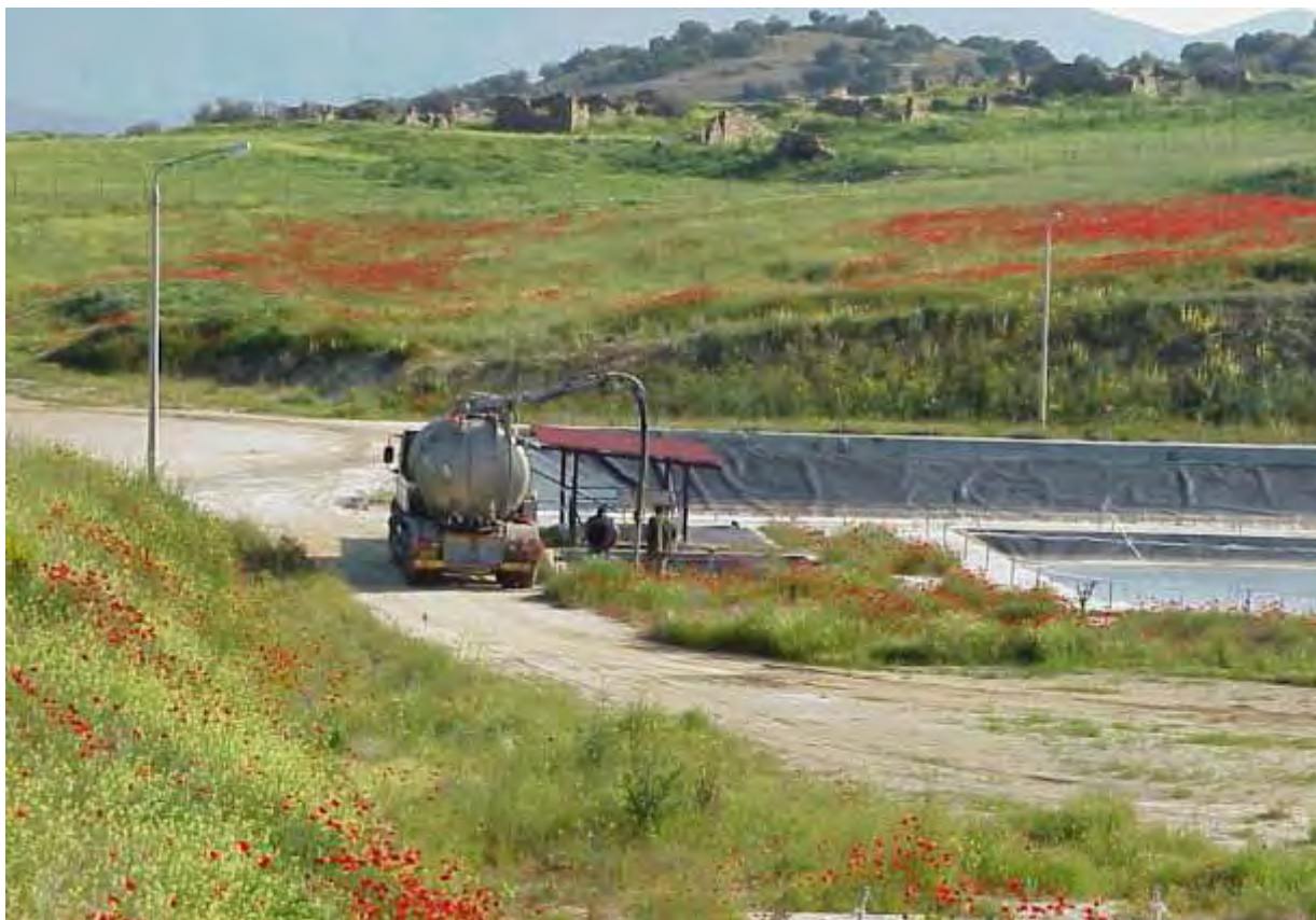
Φωτογραφία 9: Βυτιοφόρο μεταφοράς στραγγισμάτων
