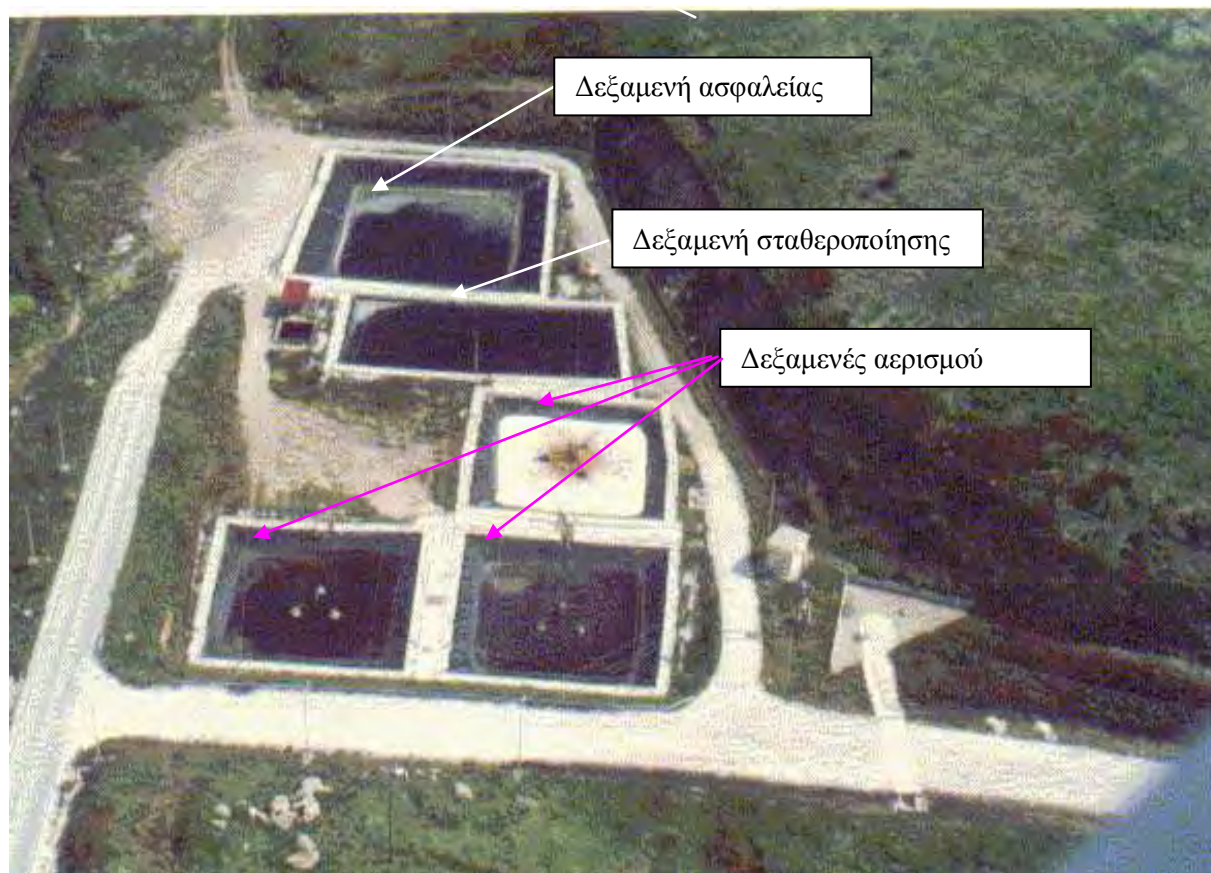
Φωτογραφία 8: Διάταξη μονάδας Βιολογικού Καθαρισμού Στραγγισμάτων
