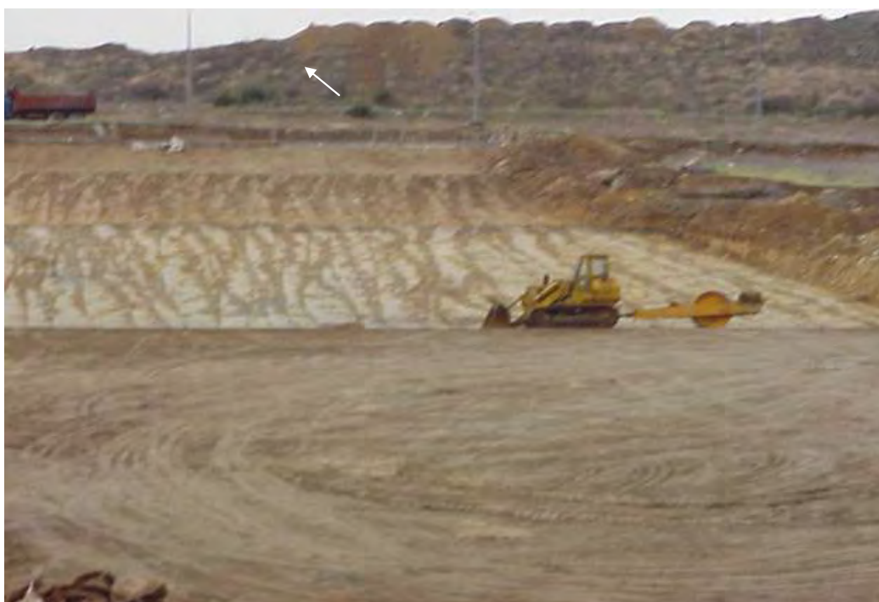
Φωτογραφία 2: Στεγανοποίηση πυθμένα ΧΥΤΑ (έργα συμπίκνωσης αργίλου)
