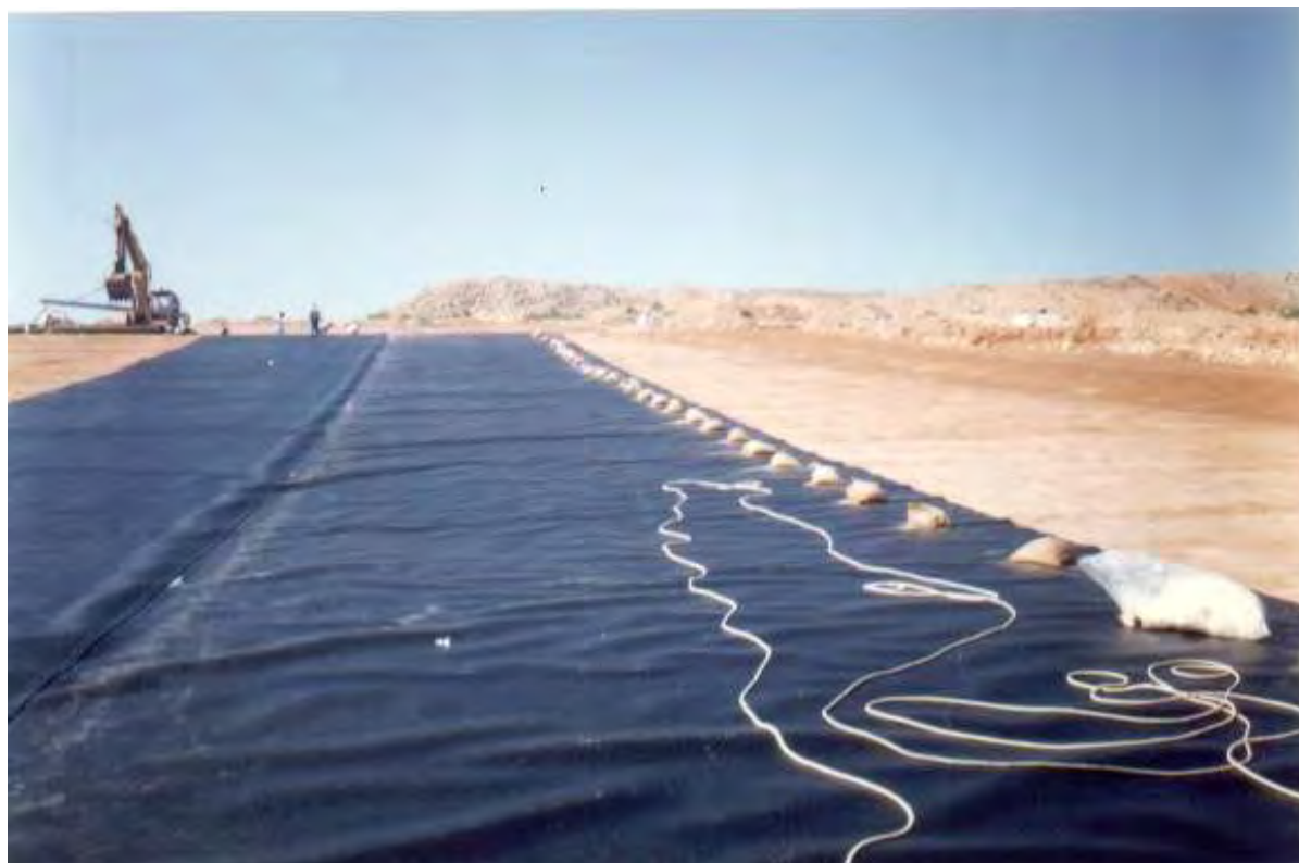
Φωτογραφία 3: Στεγανοποίηση πυθμένα με συνθετική γεωμεμβράνη HDPE
