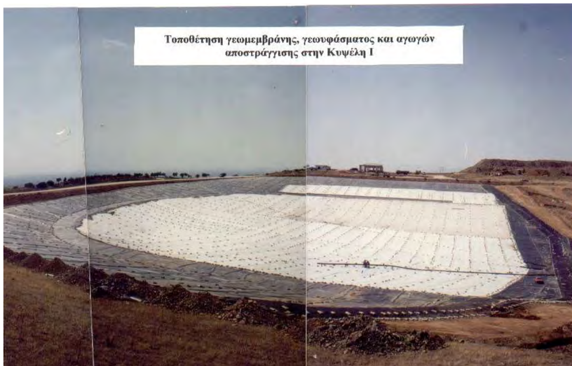
Φωτογραφία 5: Τοποθέτηση γεωμεμβράνης, γεωφάσματος, αγωγών αποστράγγισης (Κυψέλη I)
