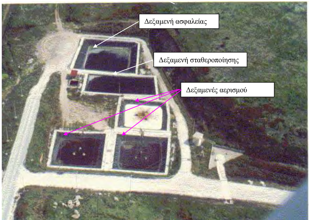
Φωτογραφία 8: Διάταξη μονάδας Βιολογικού Καθαρισμού Στραγγισμάτων
