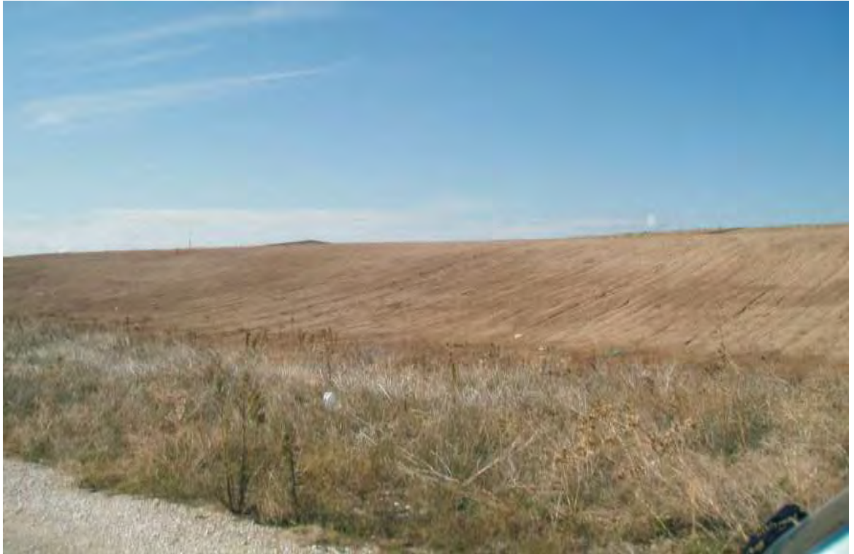
Φωτογραφία 7: Κυψέλη II – Ανενεργή υπό αποκατάσταση
