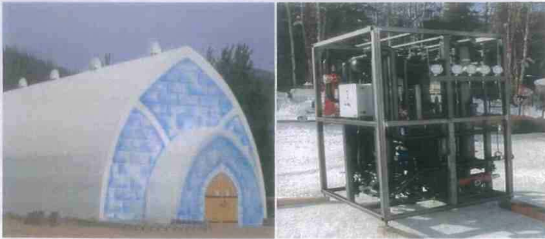
Εικόνα 5.1 – α) Εγκαταστάσεις του μουσείου πάγου στην Αλάσκα, β) Ψύκτης απορρόφησης αμμωνίας-νερού (πηγή: Chena resort 2009)
