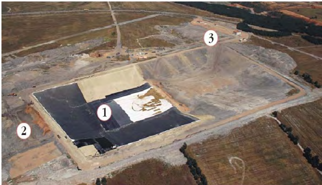
Εικόνα 2: Η κατασκευή του πρώτου κυττάρου του ΧΥΤΑ δυτικής Μακεδονίας, Αύγουστος 2004, (Διακρίνονται οι εργασίες στεγάνωσης του πρώτου κυττάρου (1), η διαμόρφωση των δεξαμενών βιολογικού καθαρισμού (2) και οι κτιριακές εγκαταστάσεις στην είσοδο του συγκροτήματος(3)), (ΠΗΓΗ: http://www.diadyma.gr )
