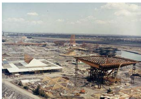
EXPO 1967 υπό κατασκευή
