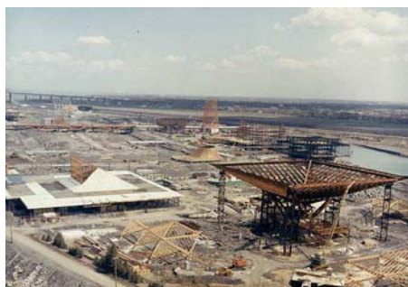
EXPO 1967 υπό κατασκευή
