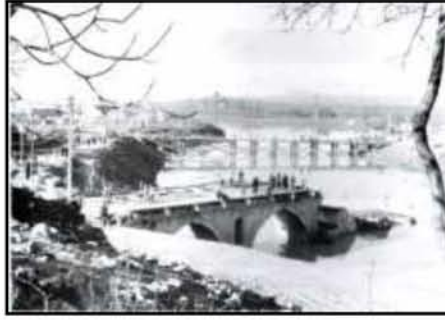
Εικόνα 18: Καταστροφή γέφυρας Πηνειού ( www.larissa-dimos.gr )
