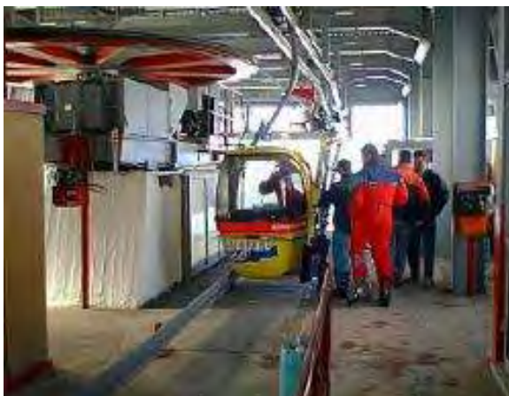
Εικόνα 3: Εναέριος αναβατήρας καμπίνας
