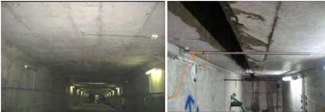
Φωτ. 1-2. Αισθητήρες δυναμικής μέτρησης: (α) παραμόρφωσης, (β) μετακίνησης αρμού
