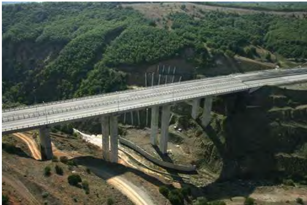
Φωτ. 1-1. Κοιλαδογέφυρα Εγνατίας Οδού
