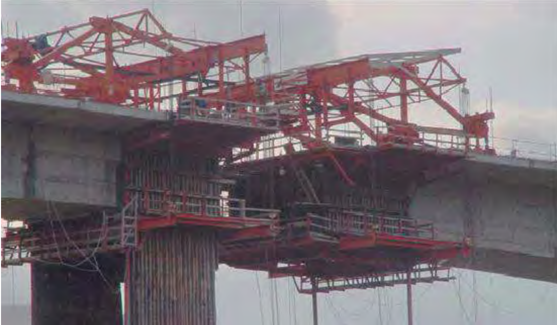
Φωτ. 2-7: Φωτογραφία από τη φάση της κατασκευής γέφυρας της Εγνατίας Οδού (Προβολοδόμηση)
