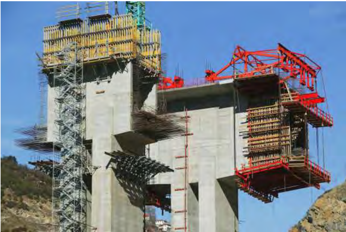
Σχήμα 2-8: Φωτογραφία από τη φάση της κατασκευής μεσόβαθρων γέφυρας της Εγνατίας Οδού
