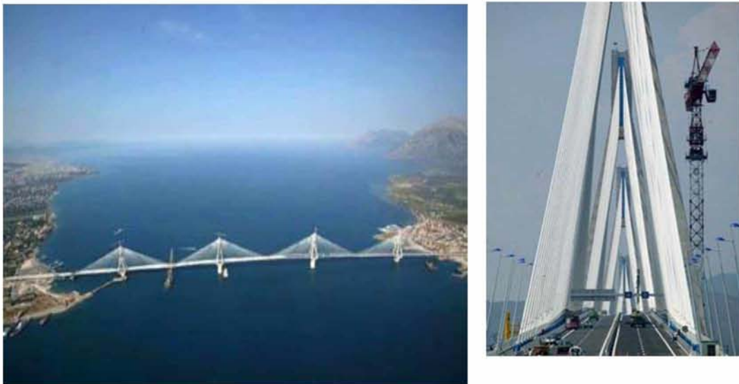
Εικόνα 3.1 και 3.2: Ζεύξη Ρίου - Αντιρρίου
