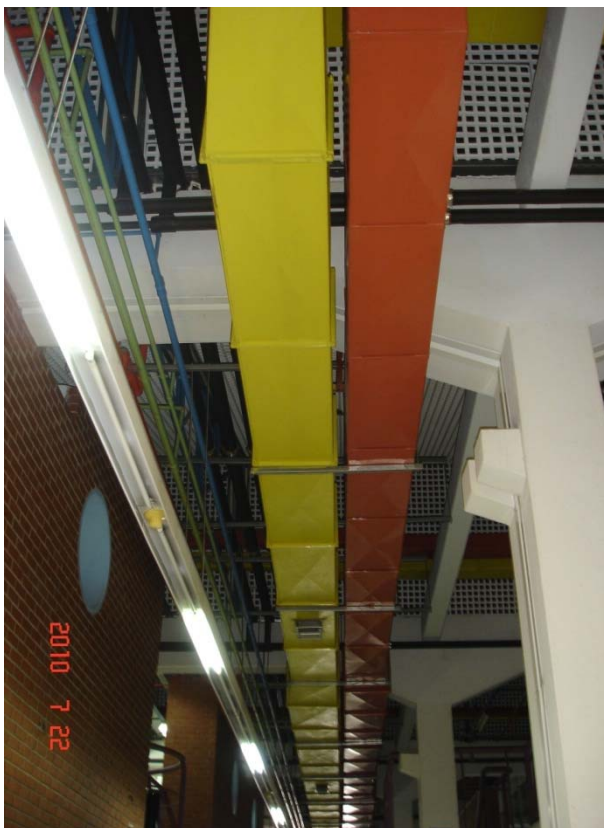
Εικόνα 86. Αεραγωγοί διανομής κλιματιζόμενου αέρα. στο διάδρομο Ο κίτρινος αεραγωγός είναι προσαγωγής ενώ ο κόκκινος είναι ο αγωγός εξαερισμού.
