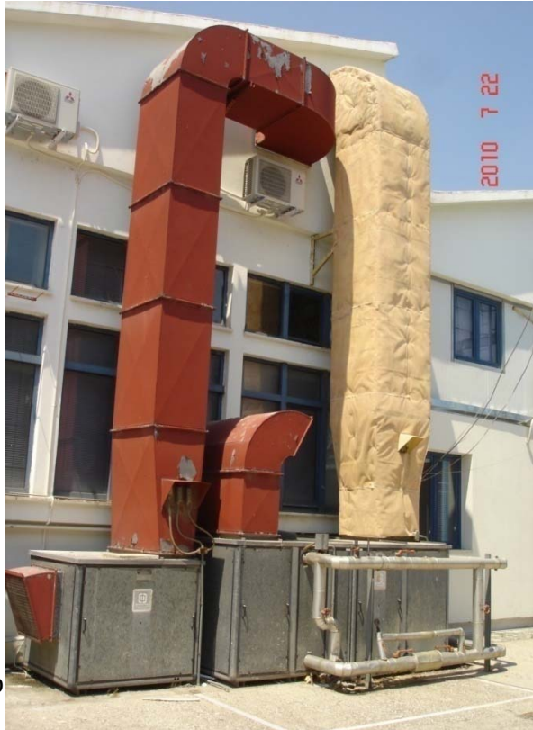
Εικόνα 85. Εξωτερική ΚΚΜ διαδρόμου – Εκτός λειτουργίας.
