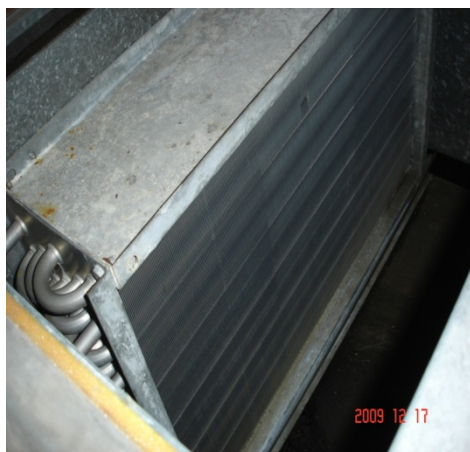
Εικόνα 82. Στοιχείο θέρμανσης – ψύξης (αριστερά) και συστοιχία φίλτρων καθαρισμού αέρα (δεξιά)
