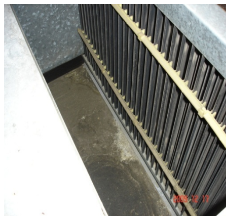
Εικόνα 82. Στοιχείο θέρμανσης – ψύξης (αριστερά) και συστοιχία φίλτρων καθαρισμού αέρα (δεξιά)
