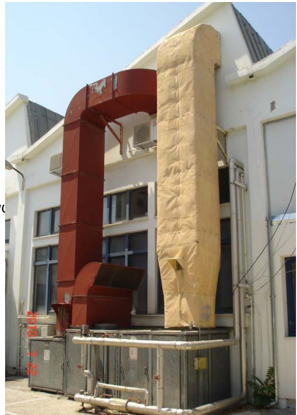
Εικόνα 85. Εξωτερική ΚΚΜ διαδρόμου – Εκτός λειτουργίας.
