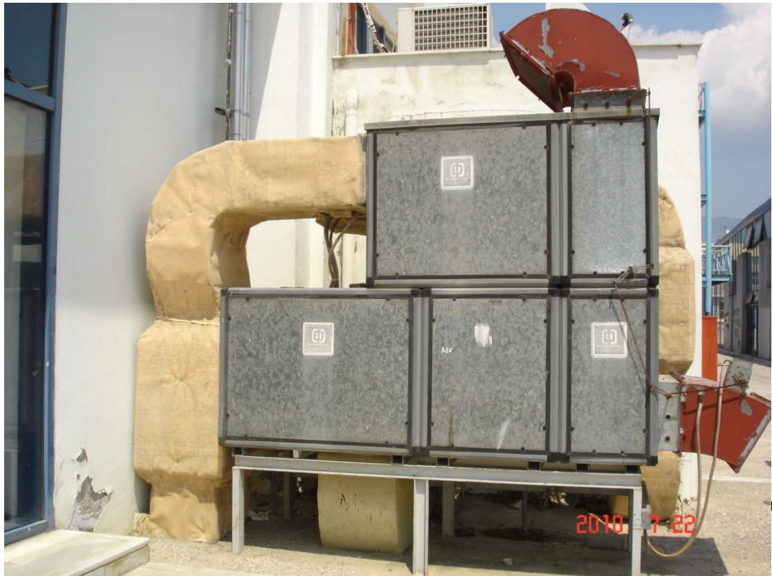
Εικόνα 83. ΚΚΜ αμφιθεάτρου
