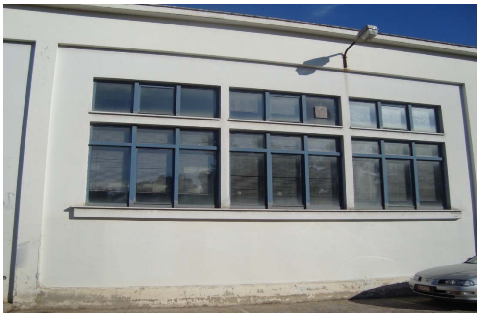
Εικόνα 57: Παράθυρα τύπου 1 και 2 περιμετρικά του κτιρίου
