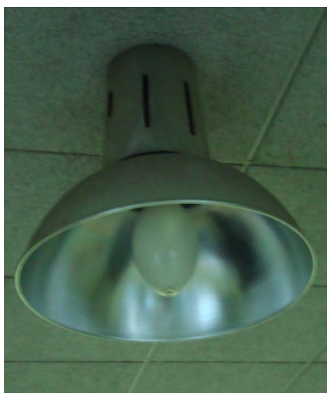
Εικόνα 94: Λαμπτήρας τύπου 2 ισχύος 500W
