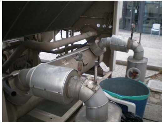
Εικόνα 91. Πίσω όψη ψυκτικής μονάδας. Διακρίνονται ο εξατμιστήρας και η είσοδος και έξοδος του νερού ψύξης
