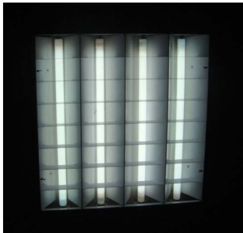
Εικόνα 92: Φωτιστικό σώμα τύπου 1 – Αποτελείται από 4 λαμπτήρες T8 (4*18W)
