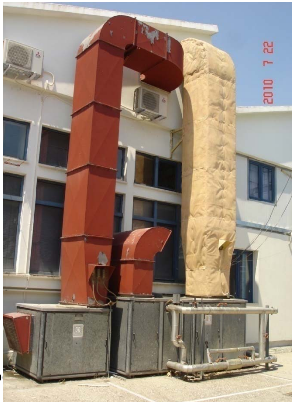
Εικόνα 85. Εξωτερική ΚΚΜ διαδρόμου – Εκτός λειτουργίας.
