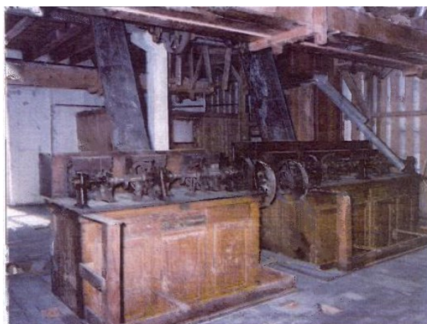
77. Το πάνω μέρος των φίλτρων αέρος στην κεντρική αίθουσα του β' ορόφου. Στην οροφή διακρίνονται κοχλίες μεταφοράς (αρχείο Δ. Λαγού)
