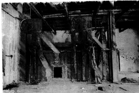
50. Τμήμα ομογενοποίησης (χαρμανιέρα) – τελευταίος όροφος
