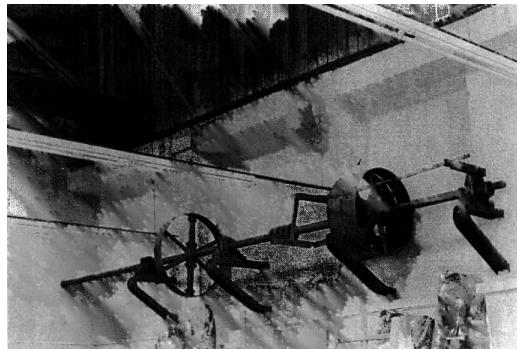
11. Τμήμα του κεντρικού άξονα κίνησης στο χώρο του μηχανοστασίου
