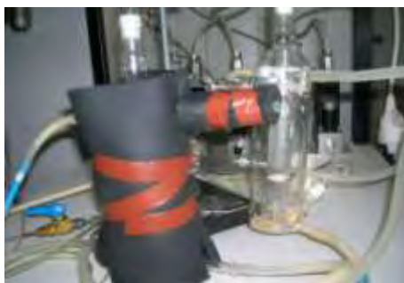
Σχήμα A.5: Σύστημα κορεστών αερίων. Η μόνωσή τους είναι απαραίτητη, τόσο για την μείωση απωλειών θερμότητας, όσο και για την αποφυγή σχηματισμού σταγόνας
