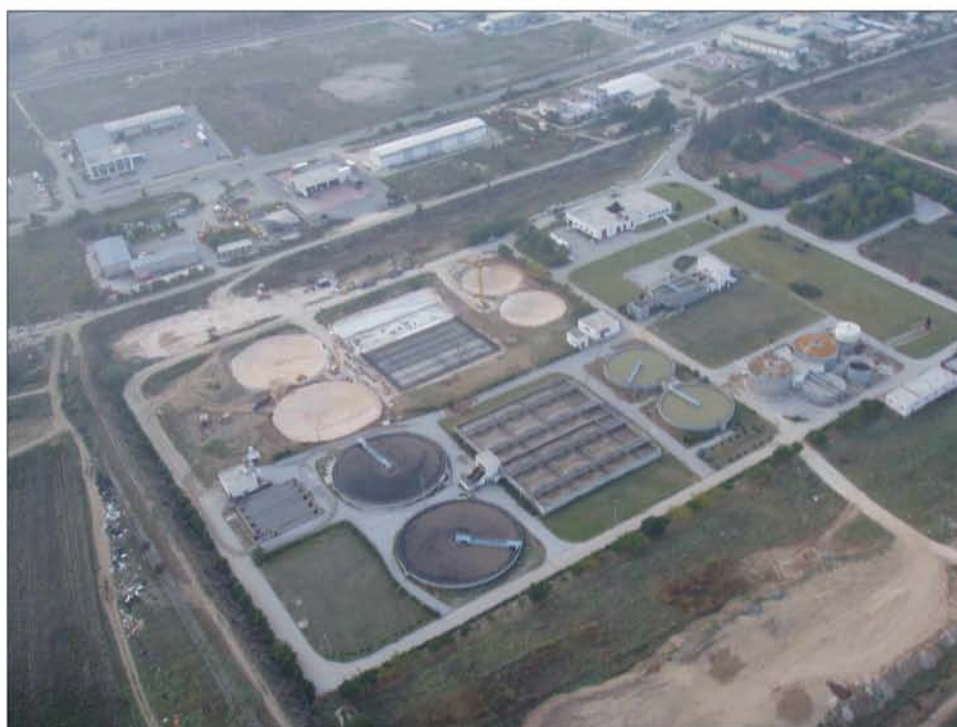
Εικόνα 4.1: Εγκατάσταση Επεξεργασίας Λυμάτων νομού Λάρισας
