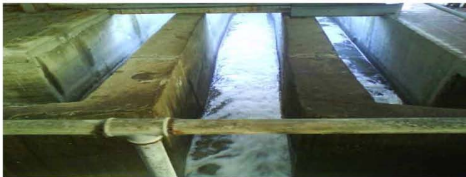
Εικόνα 4.13: Κανάλι τύπου Venturi για την μέτρηση παροχής στην ΕΕΛ Λάρισα.
