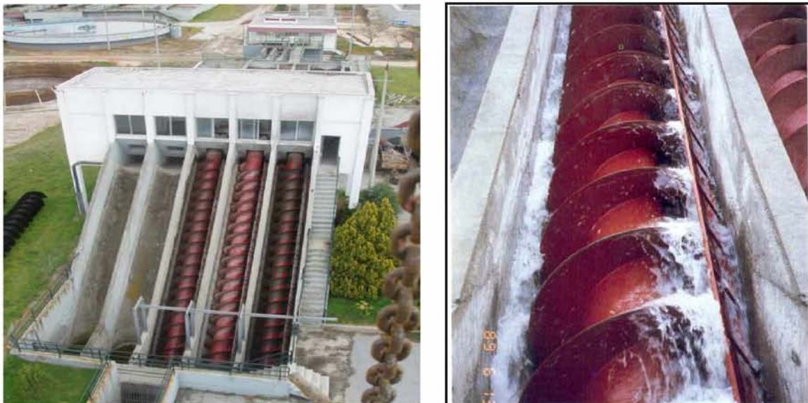
Εικόνα 4.7 - 4.8: Ανυψωτικοί κοχλίες τύπου Αρχιμήδη στην ΕΕΛ Λάρισας.
