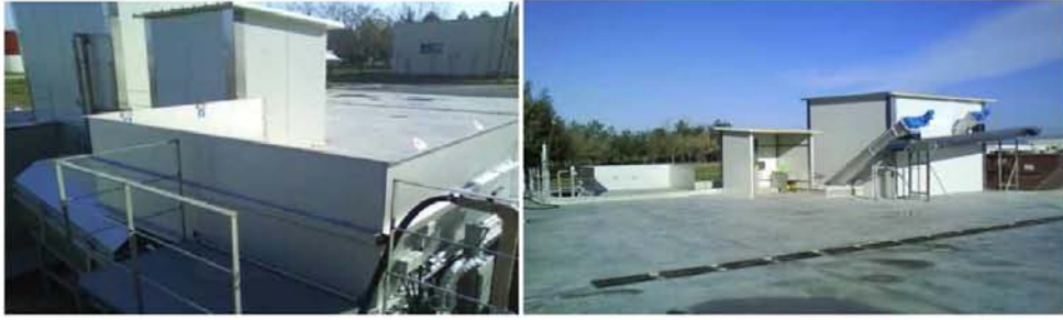
Εικόνα 4.5 – 4.6: Μονάδα επεξεργασίας λυμάτων αποφρακτικών στην ΕΕΛ Λάρισας.
