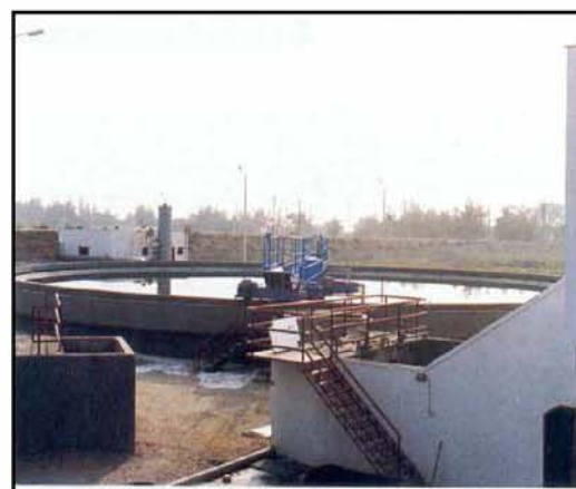
Εικόνα 4.15 – 4.16: Δεξαμενές πρωτοβάθμιας καθίζησης.
