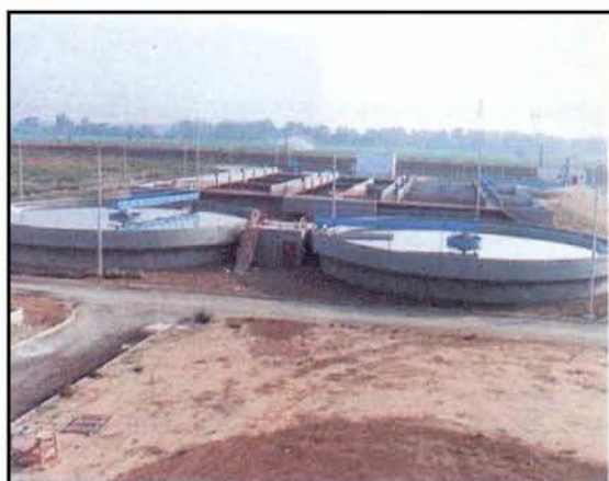
Εικόνα 4.15 – 4.16: Δεξαμενές πρωτοβάθμιας καθίζησης.
