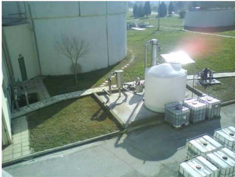
Εικόνα 4.32: Καθαρισμός του βιοαερίου από H 2 S πριν την είσοδο στις μηχανές βιοαερίου.
