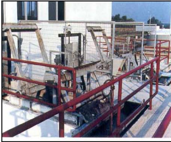
Εικόνα 4.9 - 4.10: Αντλίες αέρος για την απομάκρυνση της άμμου.
