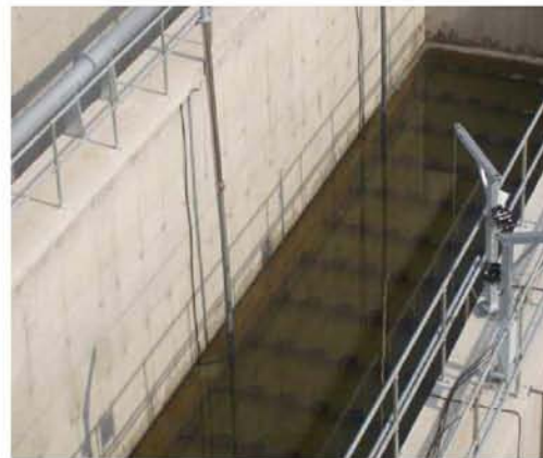
Εικόνα 4.19 – 4.20: Αερισμός και διαχυτήρες κατά την διάρκεια μη λειτουργίας της μονάδας στην ΕΕΑ Λάρισας.
