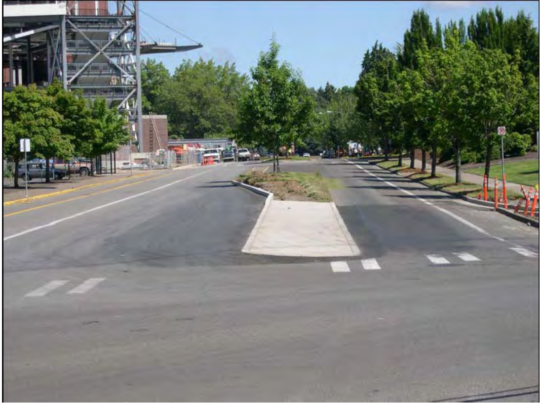
Εικόνα 5.9 Κόμβος με διαμορφωμένη λωρίδα για αριστερές στροφές εξόδου (NCHRP, 2006)
