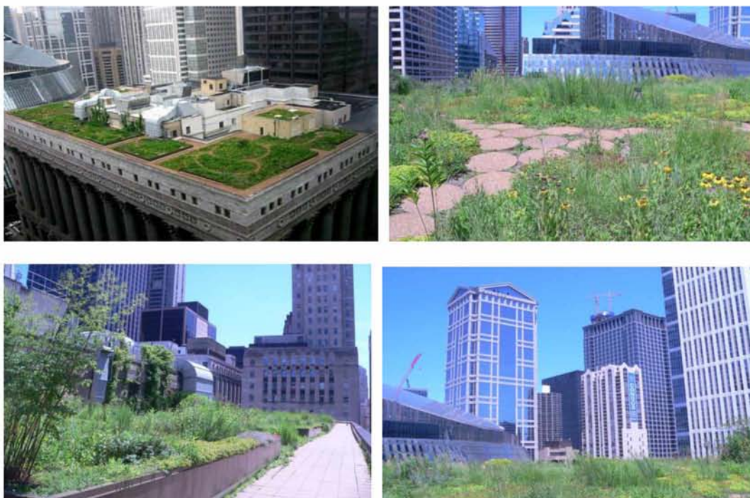
Εικόνα 14: Φυτεμένη στέγη του κτιρίου Δημαρχείου στο Σικάγο
