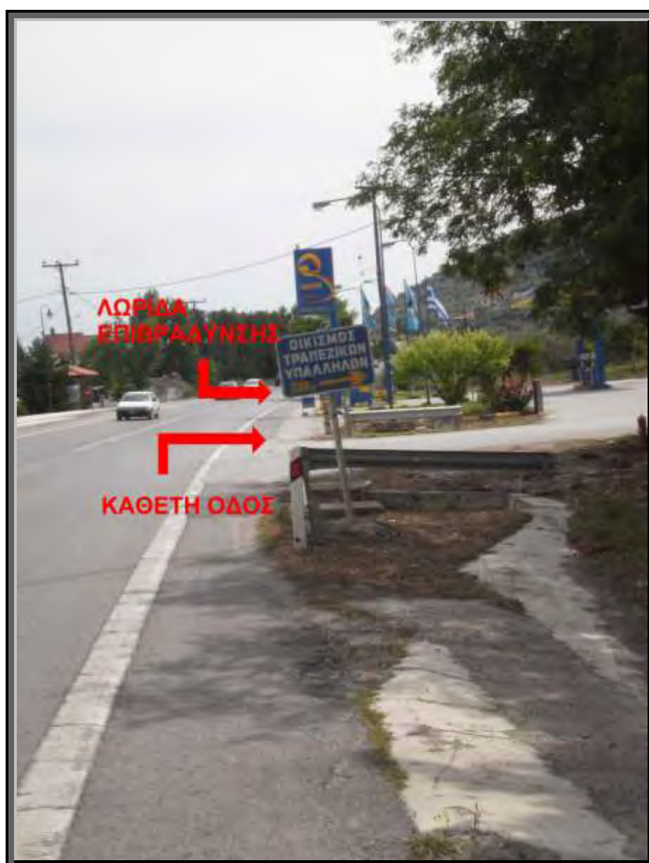
Εικόνα.16 Κάθετη οδός λίγα μέτρα πριν την αρχή της λωρίδας επιβράδυνσης
