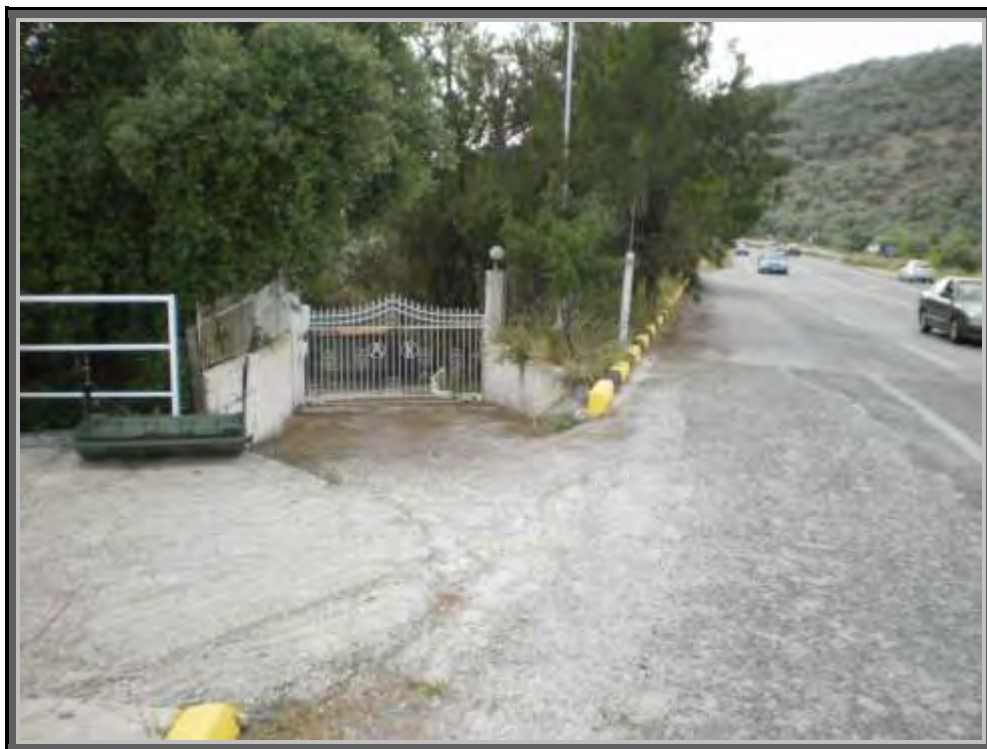
Εικόνα.15 Σημείο εξόδου από κατοικία εντός λωρίδας επιβράδυνσης
