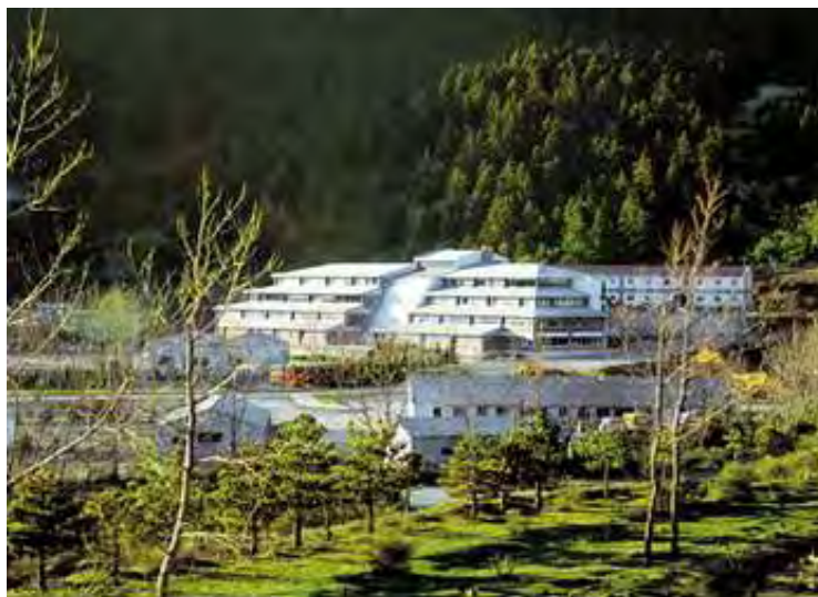
Εικόνα 20. Εγκαταστάσεις Vagonetto, Άμφισσα
