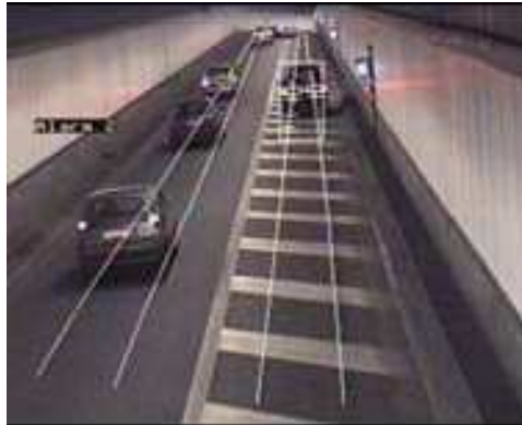
Εικόνα 3.9: Ανίχνευση σταματημένου οχήματος σε σήραγγα
