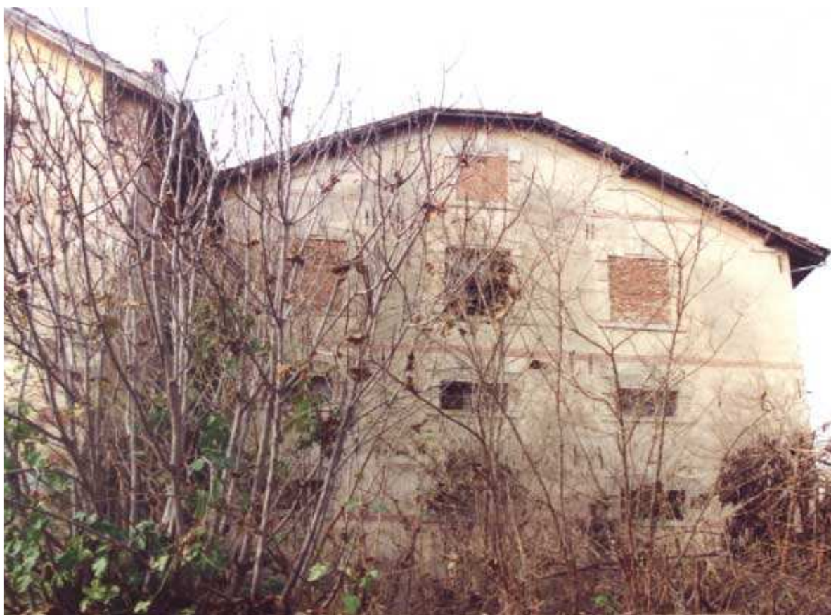
Φωτογραφία 1 Καπναποθήκη «κτίριο Πολιτισμού», Δράμα
