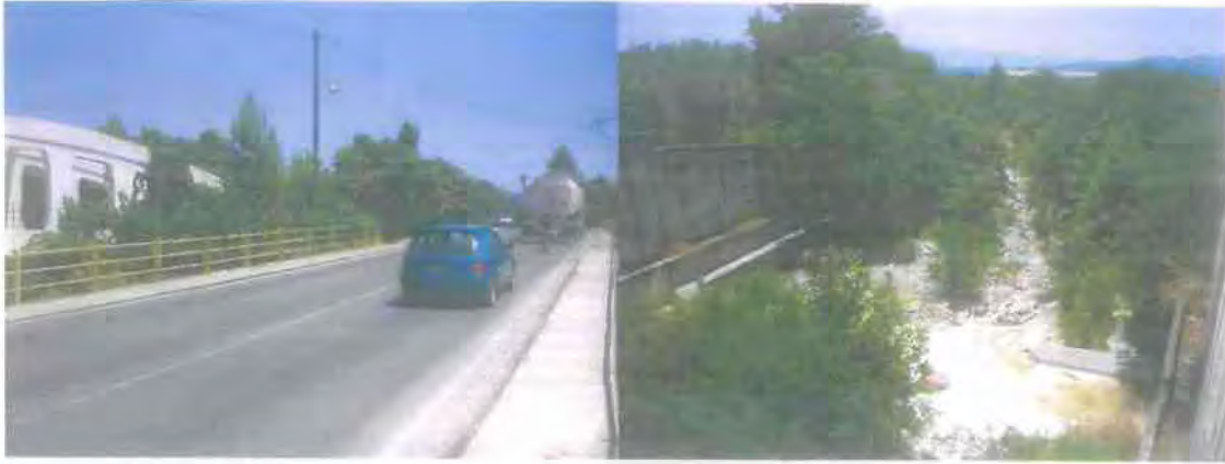
Η υφιστάμενη οδός στη διέλευση του ρέματος του Βρύχωνα.
