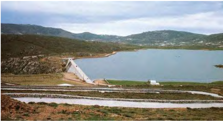
Εικ. 1: Φράγμα Μαραθιά Ν. Μυκόνου Κυκλάδων - τύπου βαρύτητας RCC (Rolled Compacted Concrete Dam)
