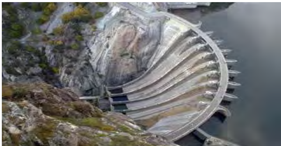
Εικ. 2: Τοξωτό φράγμα βαρύτητας στην Ισπανία (Aldeadavila Dam)
