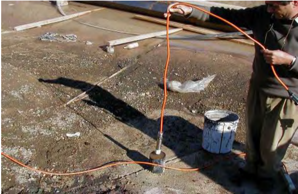
Εικ. 14: Τοποθέτηση ηλεκτρικών πιεσομέτρων.
