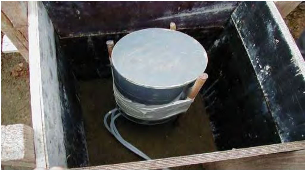
Εικ. 15: Τοποθέτηση υδραυλικού κλισιομέτρου σε αργλικό πυρήνα.
