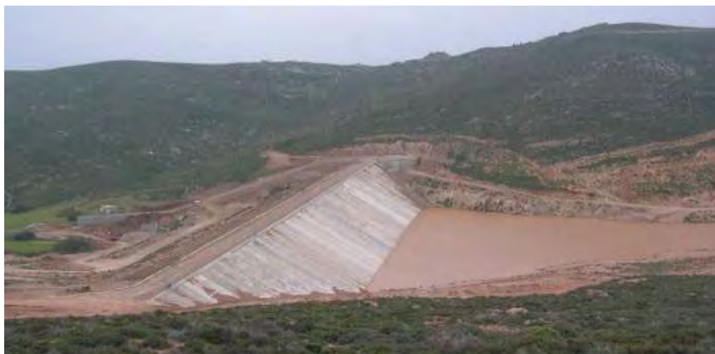
Εκ. 6: Λιθόρριπτο φράγμα με ανάντη πλάκα από σκυρόδεμα – Λειβάδι Πάτμου Λωδ/σου
