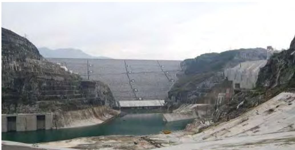
Εικ. 7: Φράγμα Shuibuya , Κίνα, Λιθόρριπτο με ανάντη πλάκα σκυροδέματος
