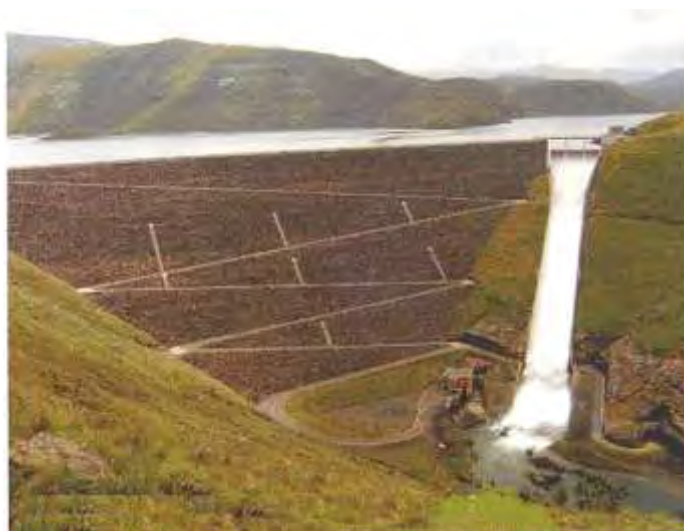
Εικ. 17: Η υπερχειλίση του Mohale μετά τις πλημμύρες.
