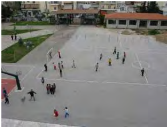
Εικόνα 2. Περιφραγμένος χώρος γύρω από το υπό κατασκευή νηπιαγωγείο
