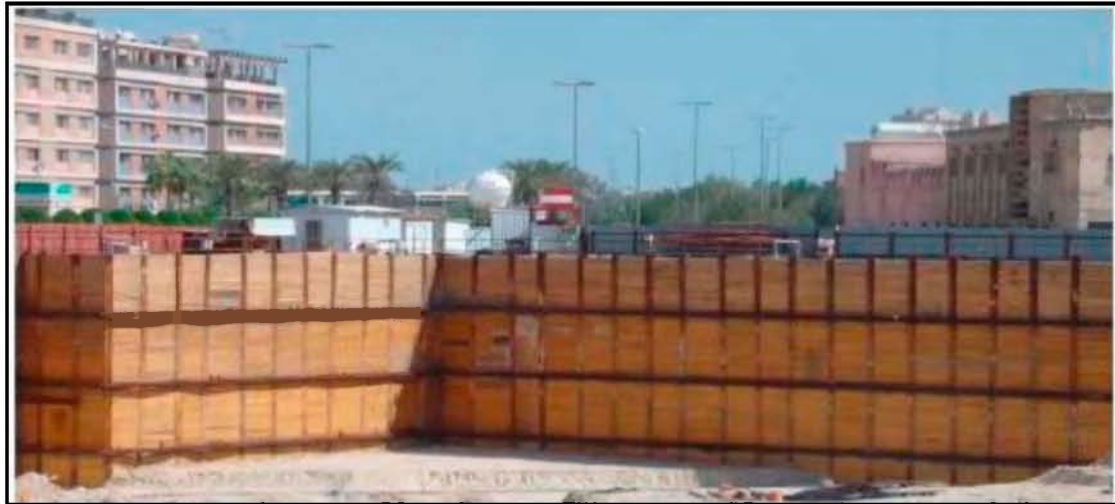
Σχήμα 2.6 Πέτασμα αντιστήριξης τύπου «Βερολίνου», (Ζερβογιάννης, 2008)
