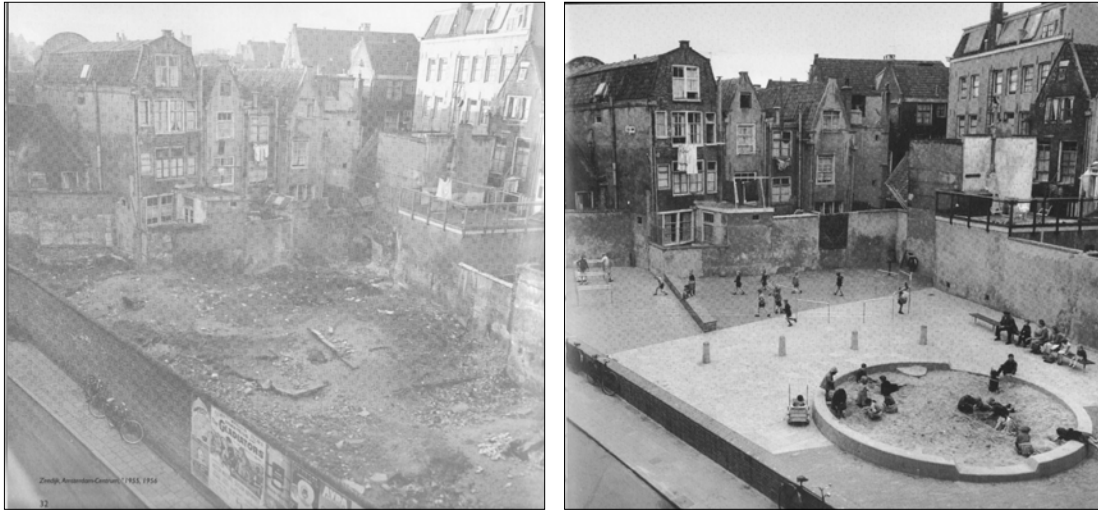
Εικόνα 14. Η παιδική χαρά στο Zeetdijk, πριν και μετά την κατασκευή (1956), την οποία επέβλεπε πάντοτε ο ίδιος ο βαν Άικ.
