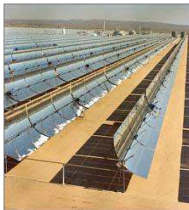
Εικόνα 3.5 Συλλέκτες Παραβολικού Κυλίνδρου (Parabolic Trough Collector)
