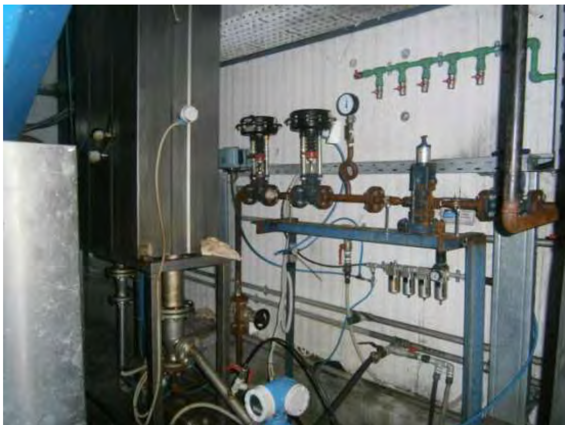
Εικόνα 30: Σύστημα κροκίδωσης.
