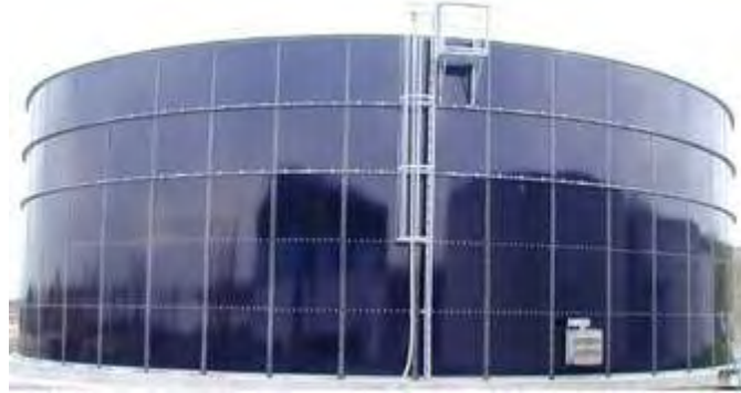
Εικόνα 41: Χωνευτήρας (βιοαντιδραστήρας). (Πηγή:
