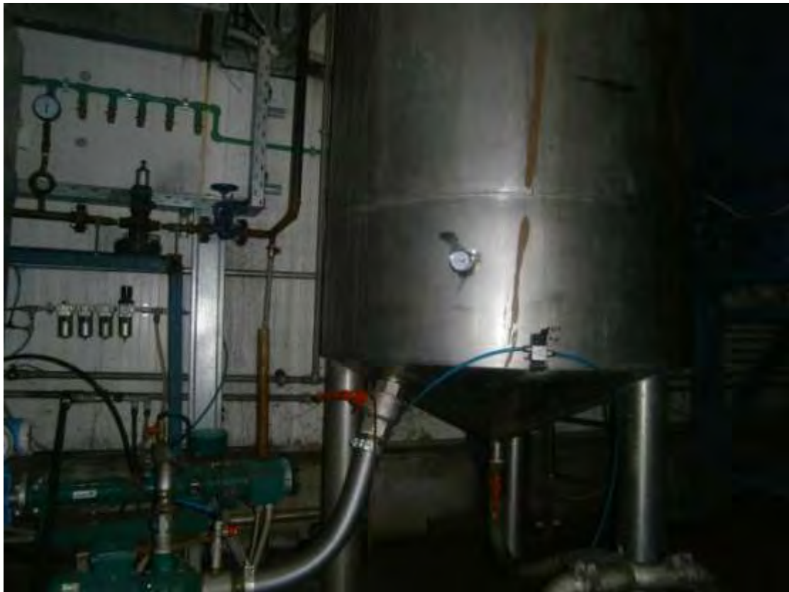
Εικόνα 29: Αντλίες τροφοδοσίας για το σύστημα κροκίδωσης (αριστερά). Δεξαμενή αποθήκευσης αίματος (δεξιά).
