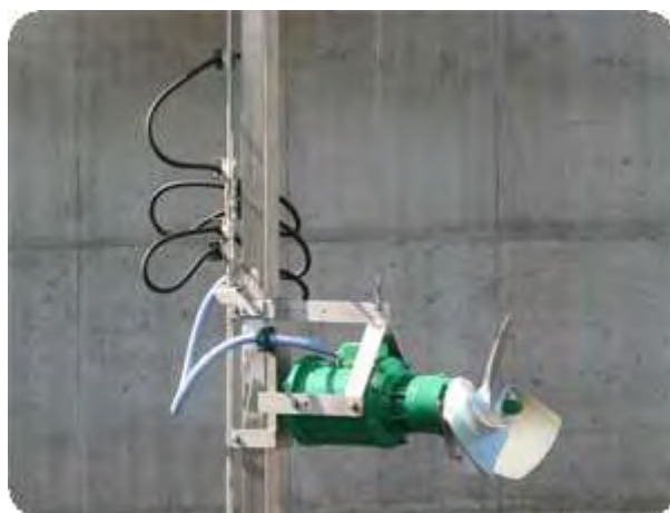
Εικόνα 45: Υποβρύχιος αναδευτήρας. (Πηγή:
