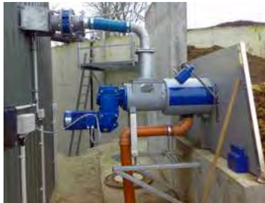
Εικόνα 47: Μηχανικός διαχωριστής υγρών/στερεών. (Πηγή:
