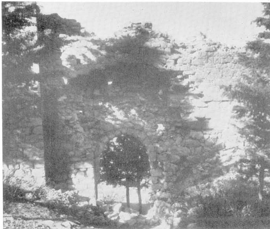
Βοιωτία: α. Λεβάδεια, Φρούριον. Πύλη Α' πρό των ἐργασιῶν, β. Πύλη Δ' πρό των ἐργασιῶν
