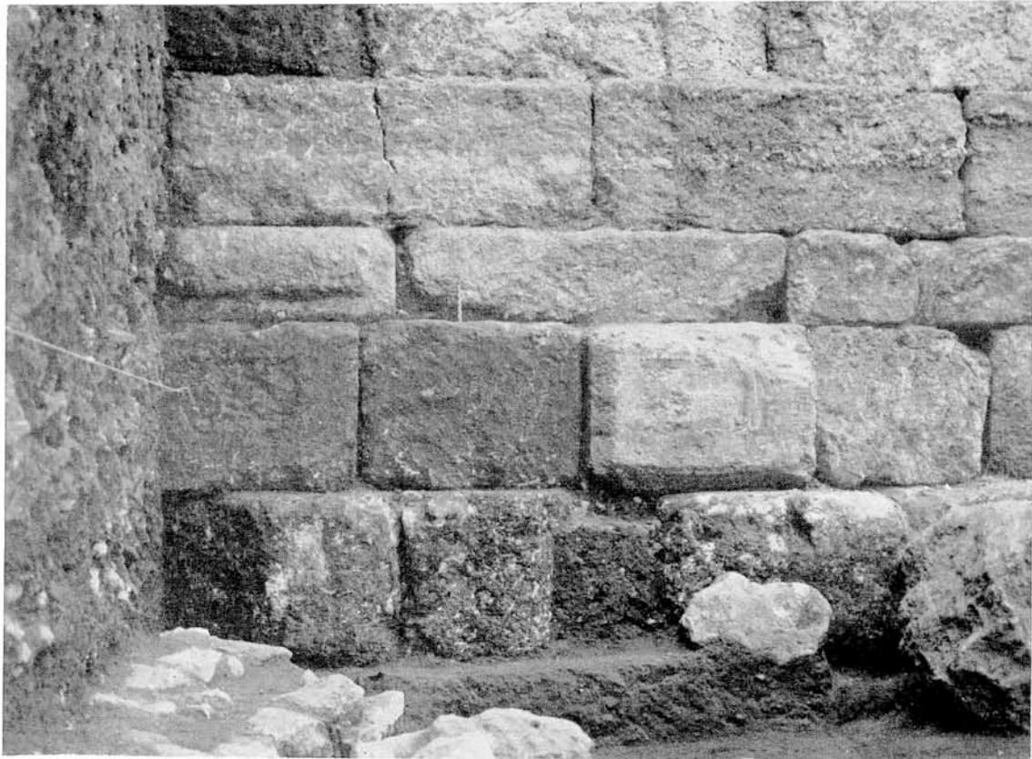
Θήβαι. Καδμείον: α - β. Δυτική και ανατολική όψεις δυτικού τοίχου κλασσικού κτηρίου
