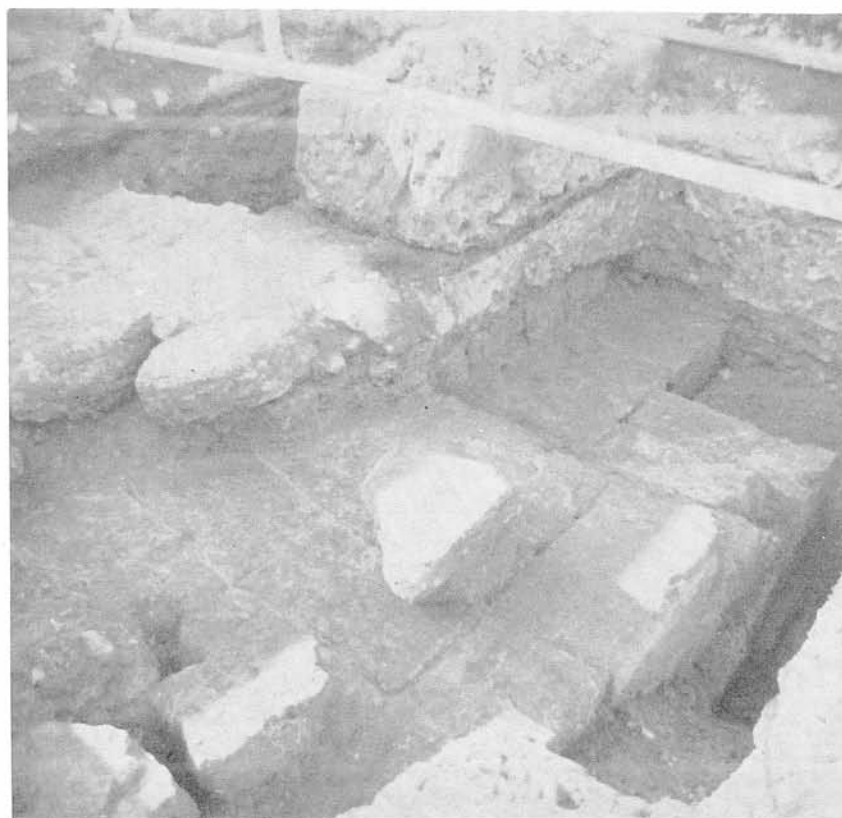
Ἀττική, Νέον Φάληρον: α. Ἐποψὶς τῶν πεδίων τῆς οἰκοδομῆς, εἰς τὰ ὅποια ἐπεσημάνθη τὸ τεῖχος, β. Ἡ ἀποκαλυφθεῖσα στρώσις λίθων τοῦ τεῖχους
