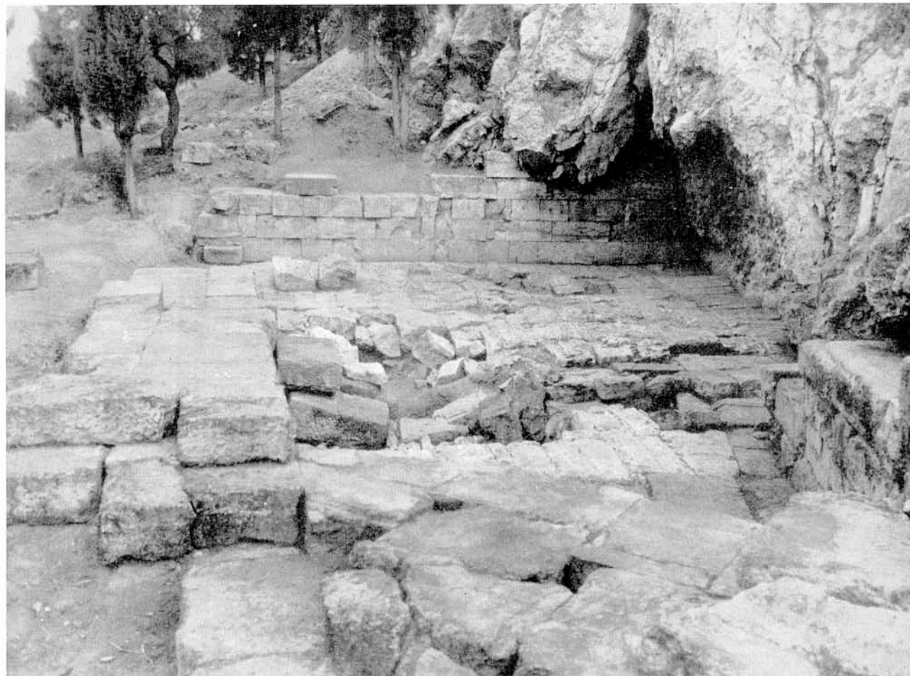
Ἀθήναι: Ἡ αὐλὴ τοῦ Πυθίου ἐκ Δ. μετὰ τὰς ἐργασίας ἀποκαταστάσεως
