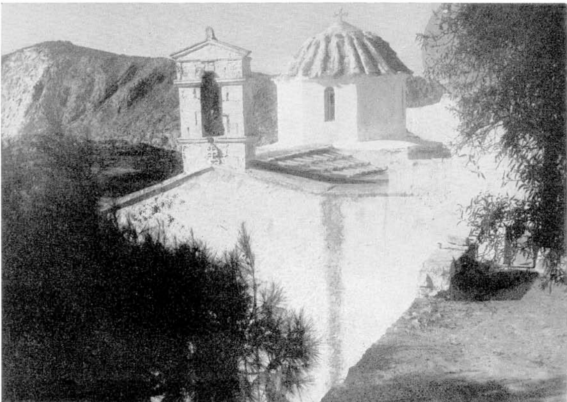
Αίγινα. Παλαιοχώρα: α. Ναός Ἁγίου Ἀθανασίου, πρὸ τῶν ἐργασιῶν, β. Ἐπισκοπή
