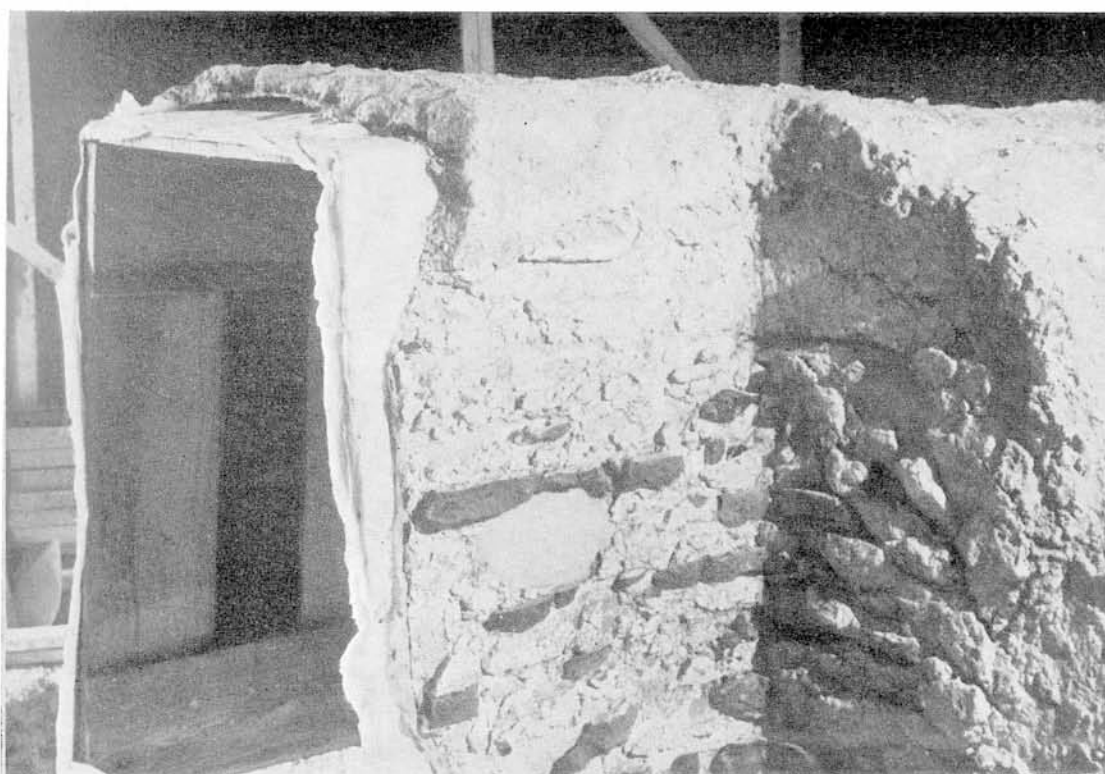
Θεσσαλονίκη. Παλαιοχριστιανικός τάφος: α. Ἐσωτερικὴ ὄψις μετὰ τὴν στερέωσιν τῆς ζωγραφικῆς, β. Ἐξωτερικὴ ὄψις τοῦ τάφου, μετὰ τὴν τοποθέτησιν τοῦ ξυλοτύπου
