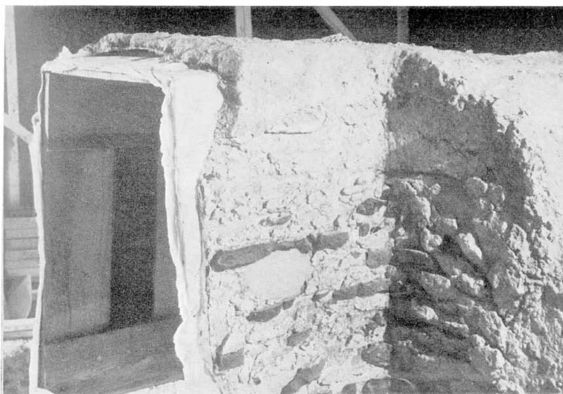
Θεσσαλονίκη. Παλαιοχριστιανικός τάφος: α. Έσωτερική όψις μετά την στερέωσιν τῆς ζωγραφικῆς, β. Ἐξωτερική όψις τοῦ τάφου, μετά τὴν τοποθέτησιν τοῦ ξυλοτύπου
