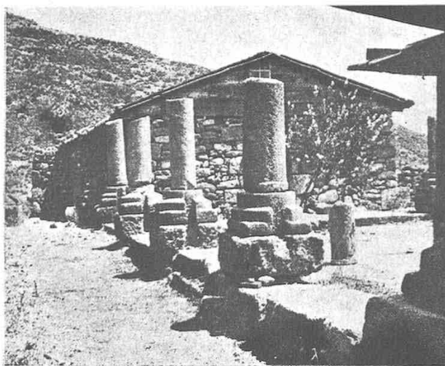
Εἰκ. 43. Στυλοβάτης τῆς δεξιᾶς κιονοστοιχίας τῆς βασιλικῆς Ἁγνηλομετώπου Λέσβου.
