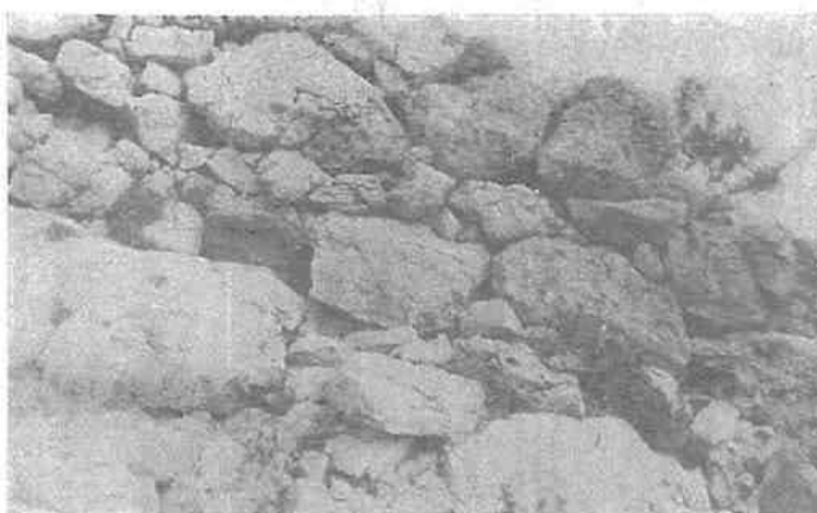
5. Ἐξωτερικὴ ἀπομὴς τοῦ δυτικοῦ τείχους
