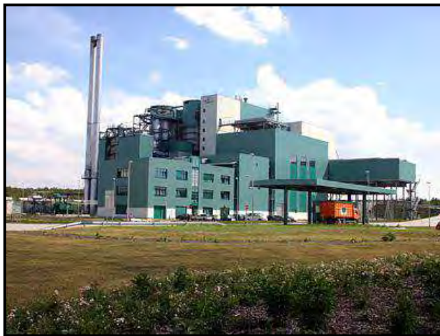
Εικόνα 11 Μονάδα αποτέφρωσης ΑΣΑ στη Γερμανία (TA Lauta, 2008)
