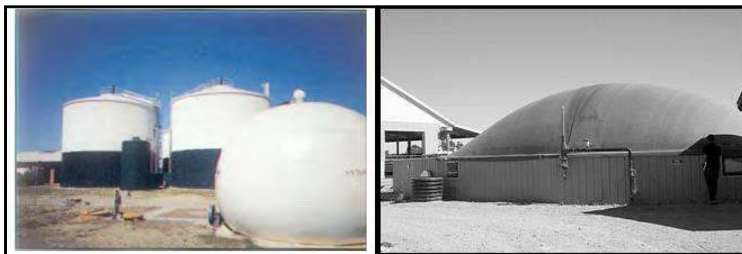
Εικόνα 13 Αντιδραστήρες αναερόβιας χώνευσης (Λαζαρίδη κ.ά, 2002)
