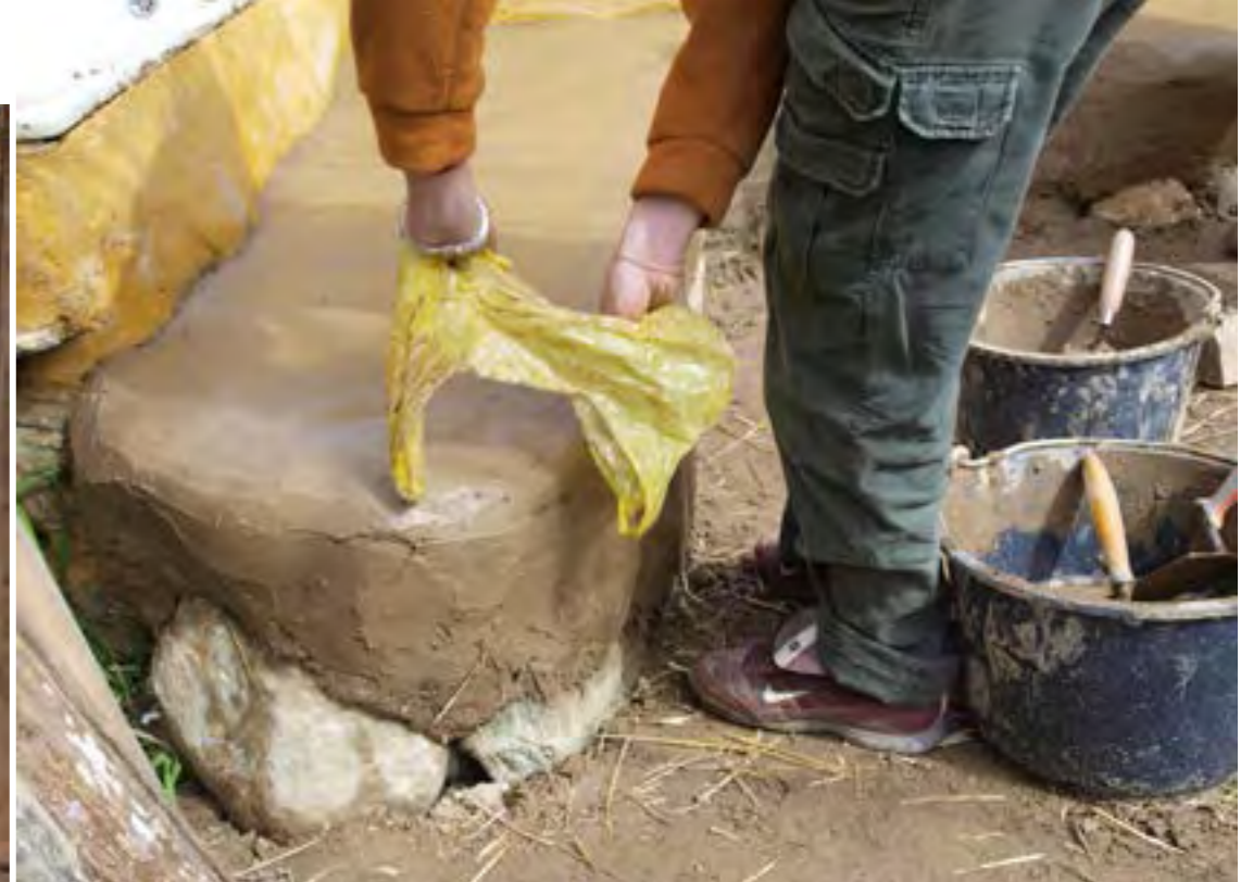
σοβάτισμα με μυστρί και σακούλα
