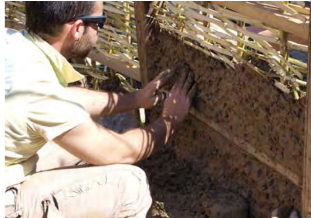
πλήρωση με υλικό
