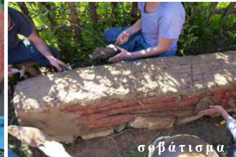
συμπύεση κάθε στρώματος με κόπανο
