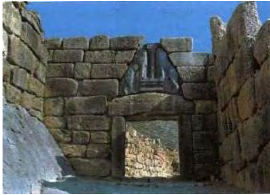
Εικόνα 1.2: Η είσοδος στην ακρόπολη των Μυκηνών. Τοίχος ηλικίας άνω των 3.500 ετών με ημικατεργασμένους ογκόλιθους (Λεγάκης, 1997).
