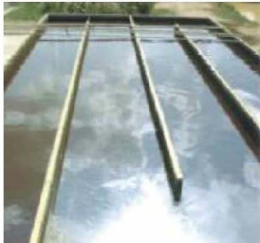
Εικόνα 4.18: Circulating watercooling pond
