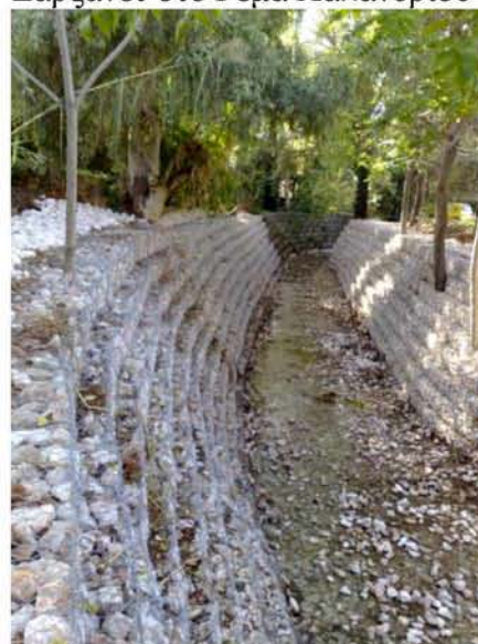
Εικόνα 5.3: Κατασκευή Σαρζανέτ στο Ρέμα Χαλανδρίου
