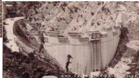
Εικόνα 3: Κατασκευή του Φράγματος
