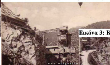
Εικόνα 2: Κατασκευή του Φράγματος
