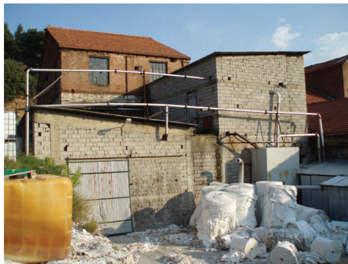
Το κτίριο με τις εγκαταστάσεις βιολογικού καθαρισμού λυμάτων.
