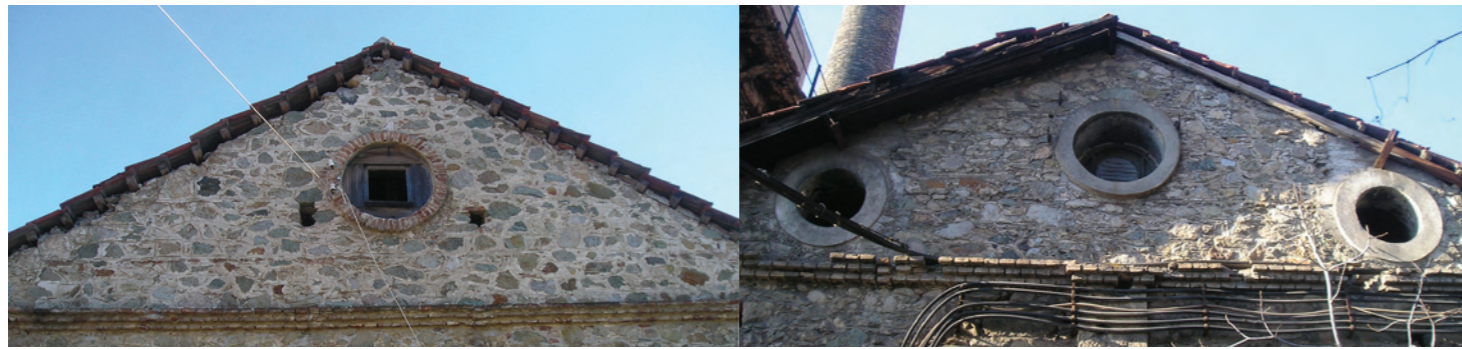
Στρογγυλοί φεγγίτες από τούβλο (αριστερά) και από τσιμέντο (δεξιά)
