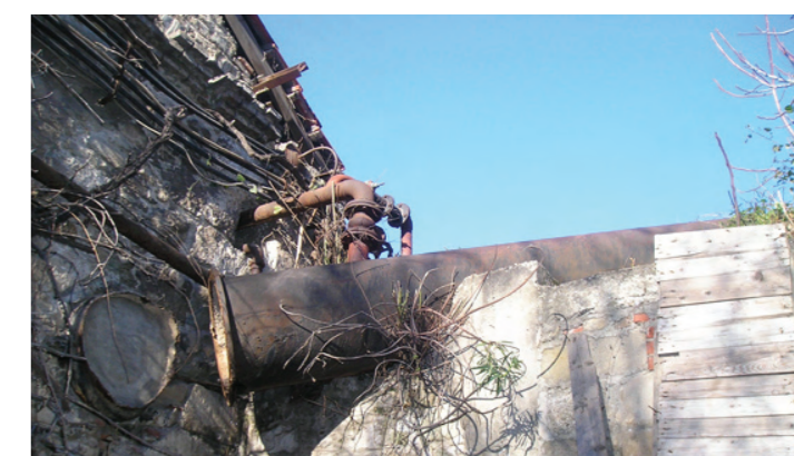
Η κατάληξη του μεταλλικού σωλήνα πτώσεως στο κτίριο όπου υπήρχε η υδροτουρμπίνα
