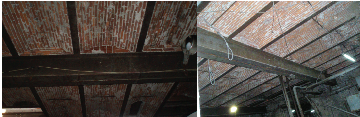
Το δάπεδο του ορόφου που ανεγέρθηκε το 1912.
