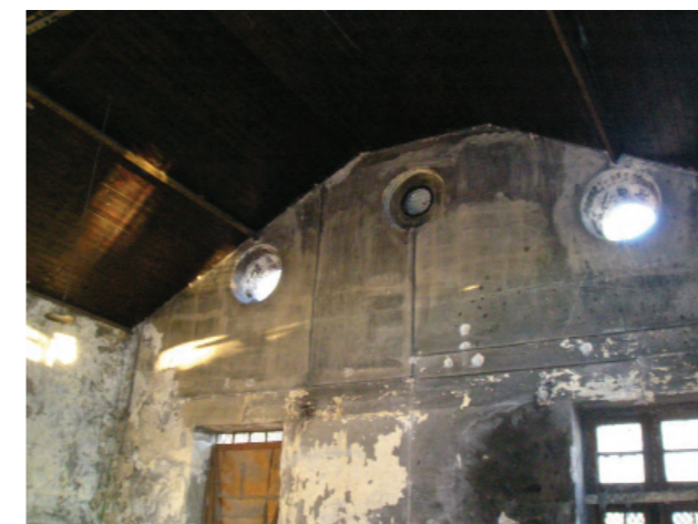
Εσωτερικά του κτιρίου του ξυλουργείου
