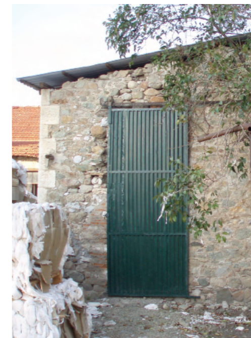
Η ποικιλομορφία των ξύλινων θυρών και συρόμενη μεταλλική θύρα (κάτω δεξιά)
