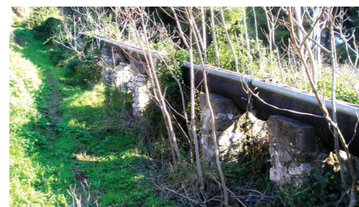
Το λιθόκτιστο υδραγωγείο και ο μεταλλικός σωλήνας πτώσεως.
