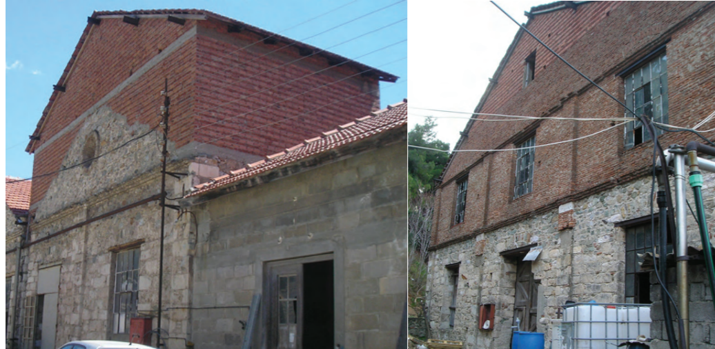
Υπερύψωση των κτιρίων από διάτρητο τούβλο.
