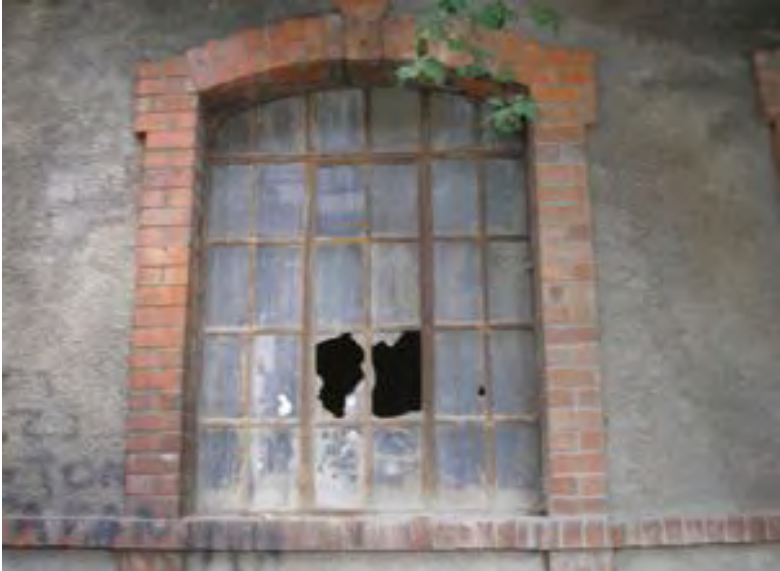
Παράθυρο του κτιρίου προς την οδό Πολυμέρη. Χαρακτηριστικό το περίγραμμα από διακοσμητικά τούβλα, καθώς και η ποδιά από το ίδιο υλικό. (πηγή : προσωπικό αρχείο.2006)
