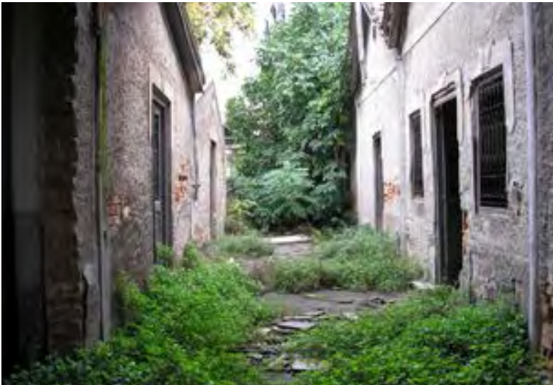
Διάδρομος που χωρίζει τα δύο τμήματα του κτιρίου (πηγή : προσωπικό αρχείο, 2006)
