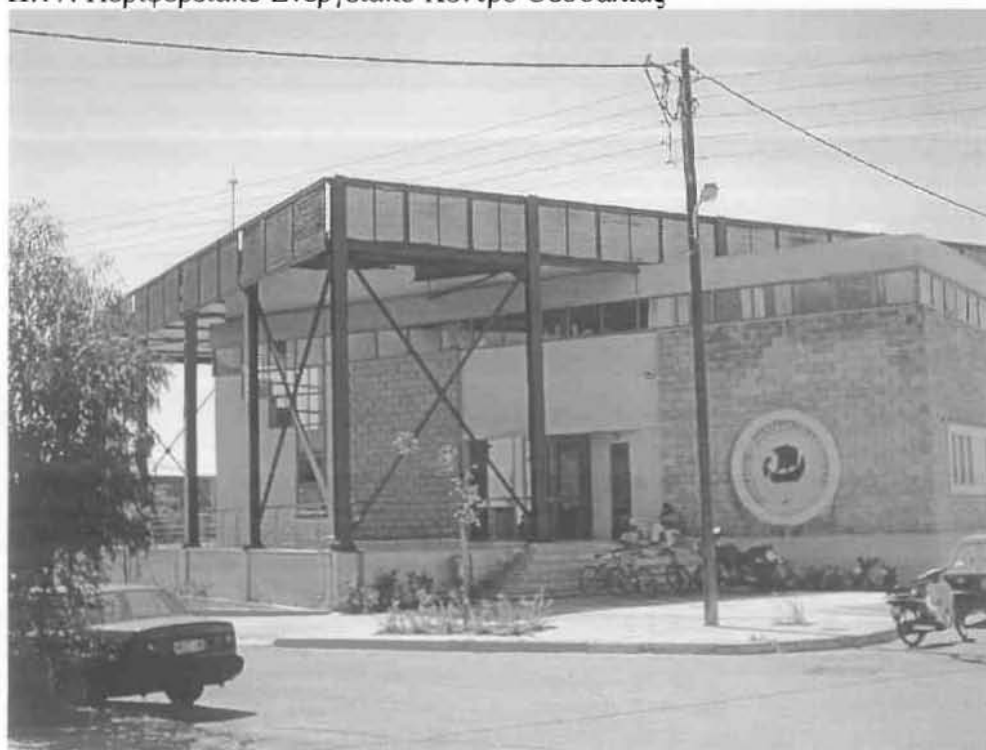
Εικ. Π.17: Περιφερειακό Ενεργειακό Κέντρο Θεσσαλίας
