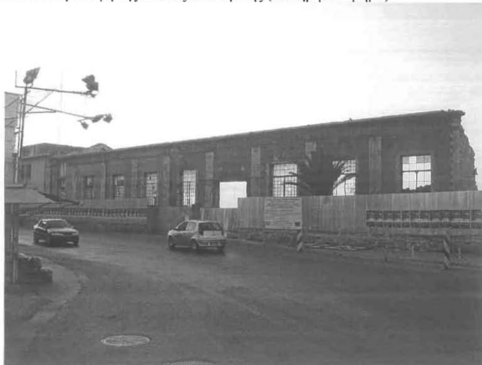
Εικ. Π.19: Η πρόσοψη της Παλιάς Ηλεκτρικής (διατηρηθέν τμήμα)
