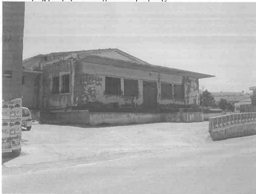
Εικ. Π.28: Περιοχή Καράβολα. Δείγματα υποβάθμισης
