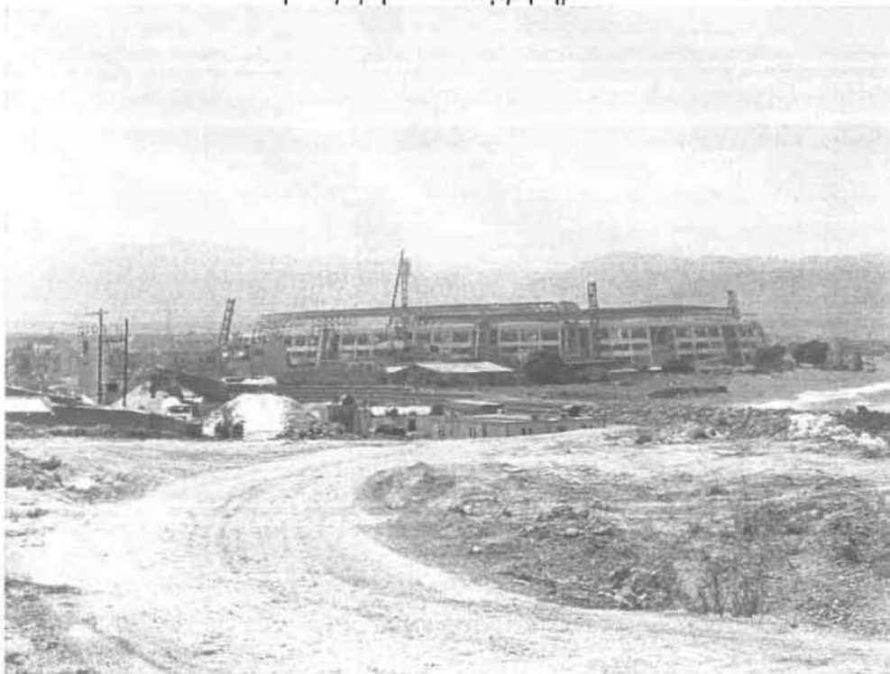
Εικ. Π.30: Το υπό κατασκευή Παγκρήτιο Κολυμβητήριο
