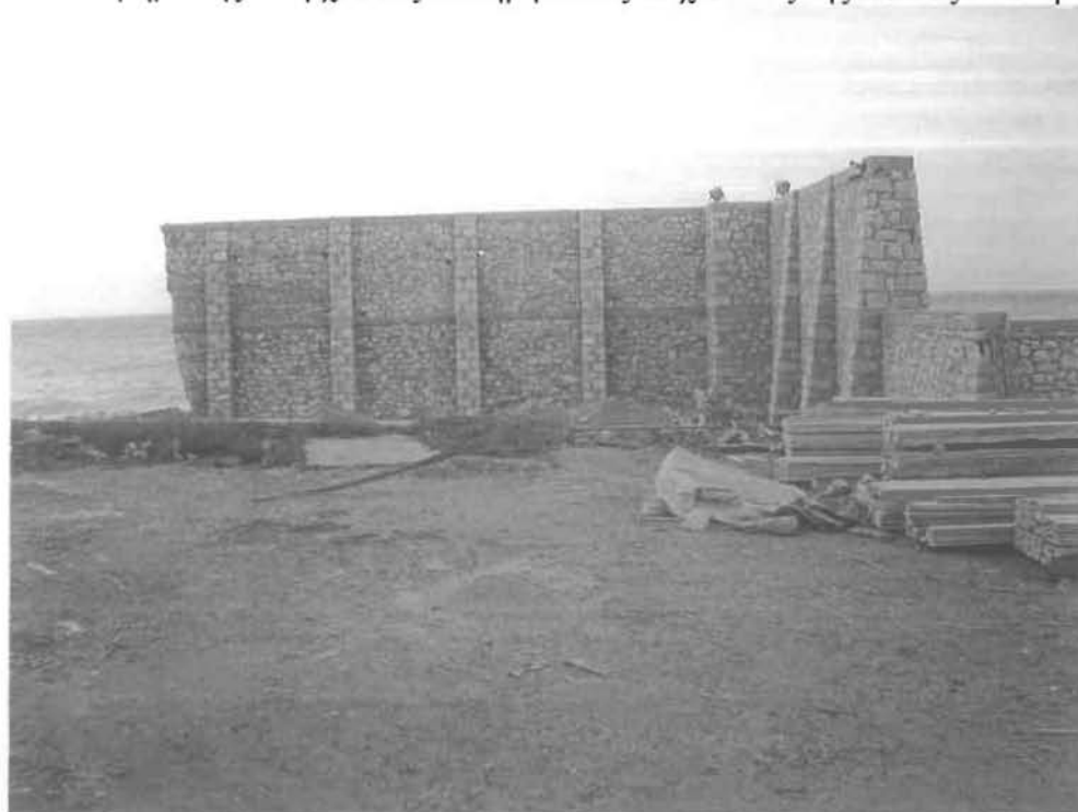
Εικ. Π.20: Τμήμα της υπάρχουσας διατηρηθείσας τοιχοποιίας της Παλιάς Ηλεκτρικής
