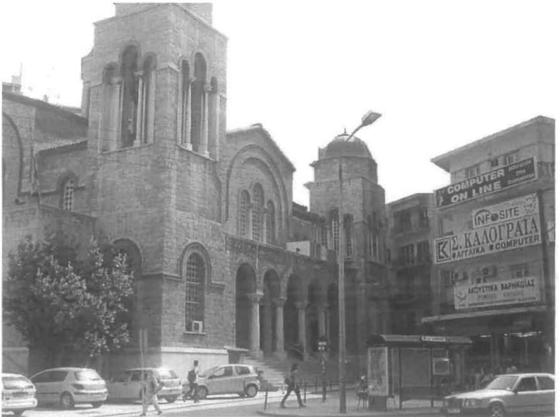
Εικόνα 13. Πρόταση καθαίρεσης ορόφων. Ι.Ν. Παναγίας Δεξιάς – Φωτομοντάζ της εφαρμογής.
