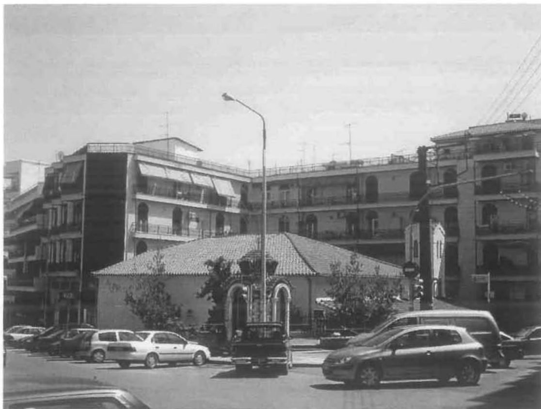
Ι.Ν. Λαοδηγήτριας – Κατεδάφιση κτιρίων για σχηματισμό πλατείας γύρω από την εκκλησία.
