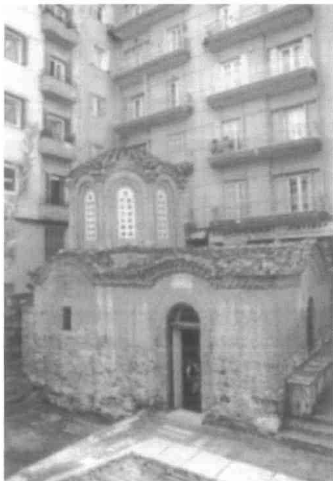
Εικόνα 11. Ύψη εκτός κλίμακας. Και κτίρια σύγχρονα κτίρια σε ελάχιστη απόσταση από τα μνημεία. I.N. Μεταμόρφωσης Σωτήρος
