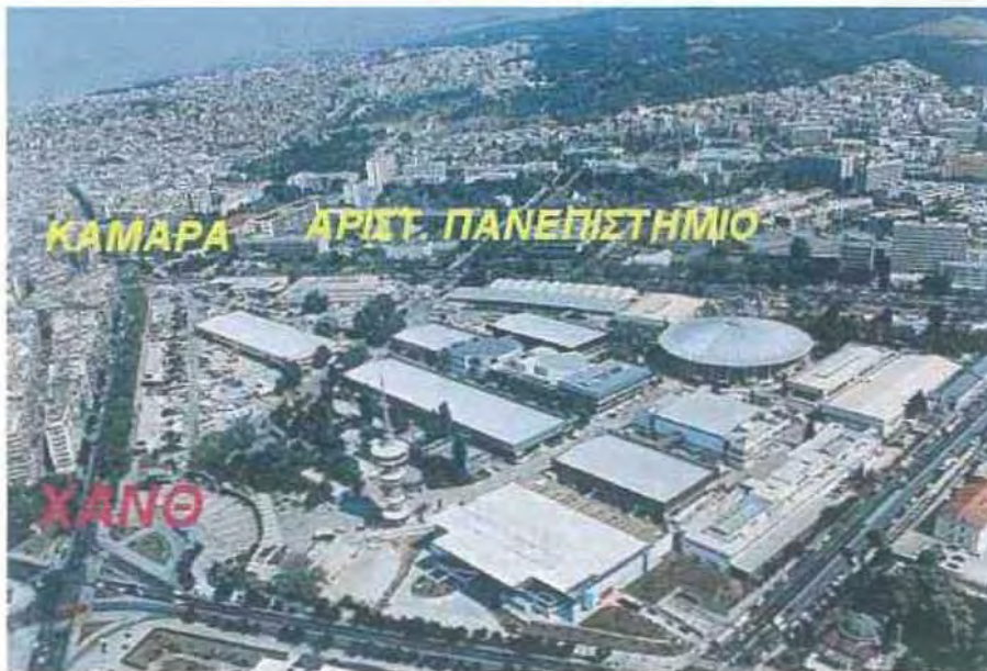
Η πρώτη πύλη και οι εγκαταστάσεις της Δ.Ε.Θ.
