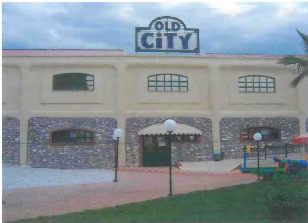
Εικόνα 3.7 : Άποψη του κτιρίου Δ (προσωπικό αρχείο).
