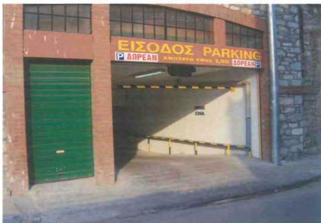
Εικόνα 3.10 : Είσοδος parking στο χώρο του OLD CITY (προσωπικό αρχείο).
