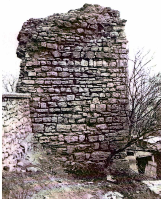
Εικόνα 46: Φέρες. Πύργος 1, στα νοτιοδυτικά. Φωτογραφία τραβηγμένη από τα νότια.
