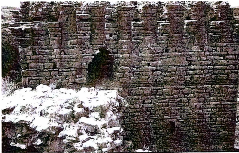
Εικόνα 33: Πύθιο. Μεγάλος πύργος. Νότια πλευρά. Πρόβολοι. Πηγή εικόνας: Τσουρής, Μπρίκας 2002
